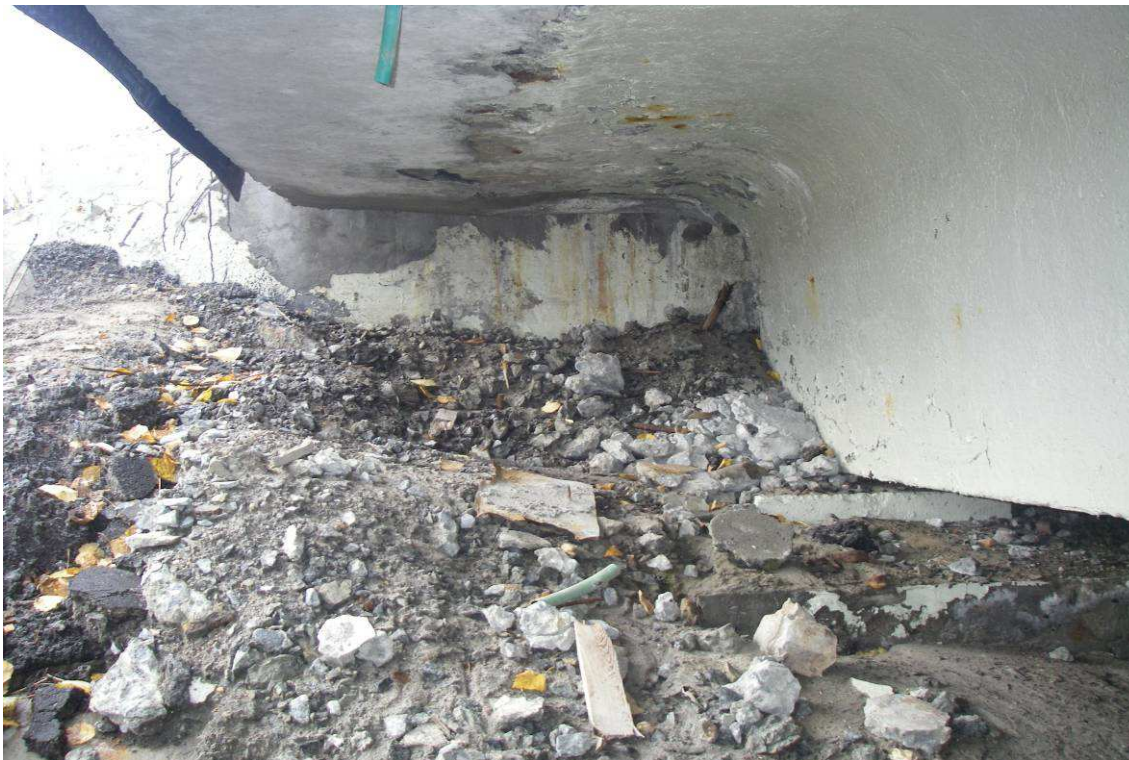
Рис. 13. Опора №1, правая сторона. Загрязнение горизонтальной поверхности насадки и подферменной площадки грунтом и обломками бетона
