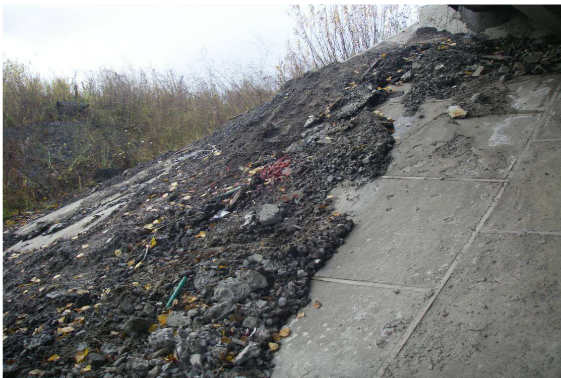
Рис. 18. Опора №1, правая сторона. Загрязнение поверхности укрепления конуса насыпи
