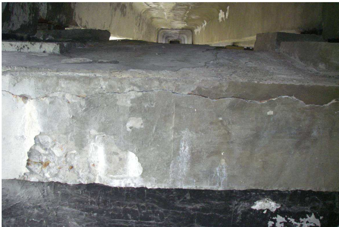
Рис. 32. Опора №5, правая сторона, вид от опоры №6. Горизонтальная трещина в блоке насадки вдоль рабочей между балками №6-7 на величину защитного слоя бетона
