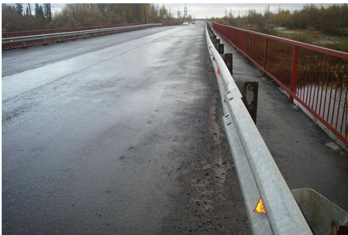
Рис. 2. Начало моста, правая сторона, вид от начала моста. Конструкция ограждения безопасности не соответствует нормативным требованиям, механические повреждения компенсаторов жесткости, отсутствует разметка проезжей части на мосту
