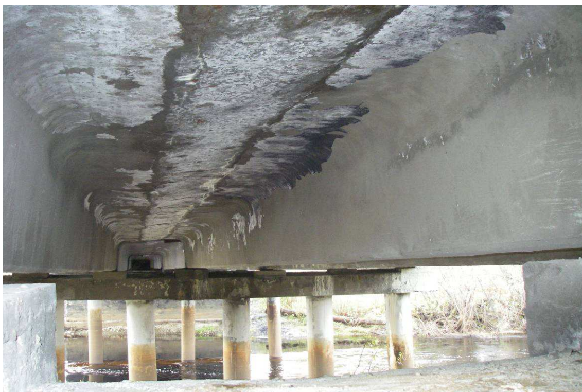
Рис. 30. Пролетное строение №4 между балками №4-5. Образование щелочного налета на нижней поверхности плиты балок и шва омоноличивания
