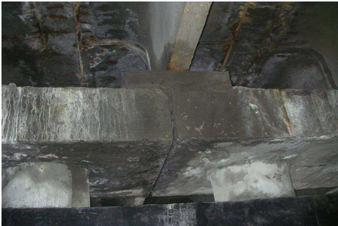
Рис. 21. Насадка опоры №2. Протечки через зазор ДШ со следами выщелачивания бетонной поверхности
