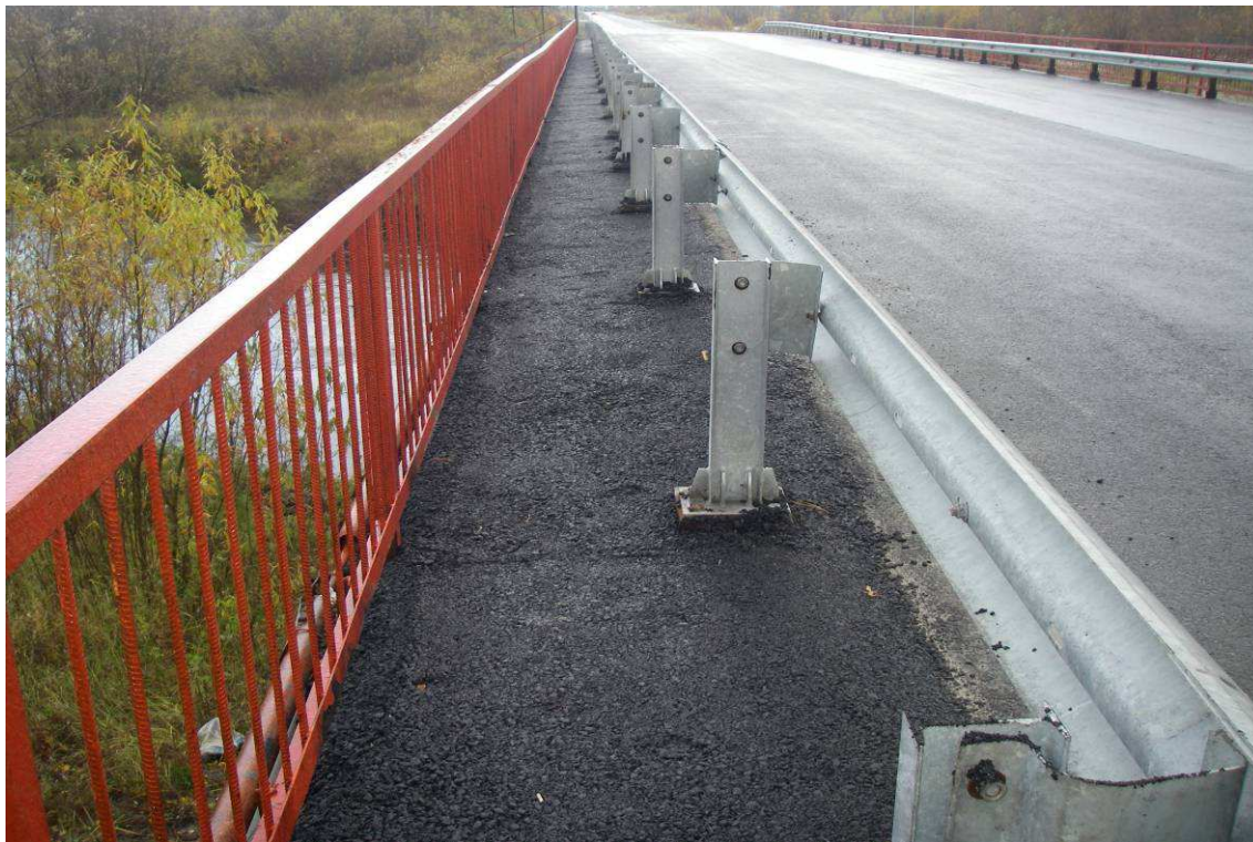
Рис. 5. Начало моста, левая сторона. Конструкция и схема установки ограждения безопасности не соответствует нормативным требованиям
