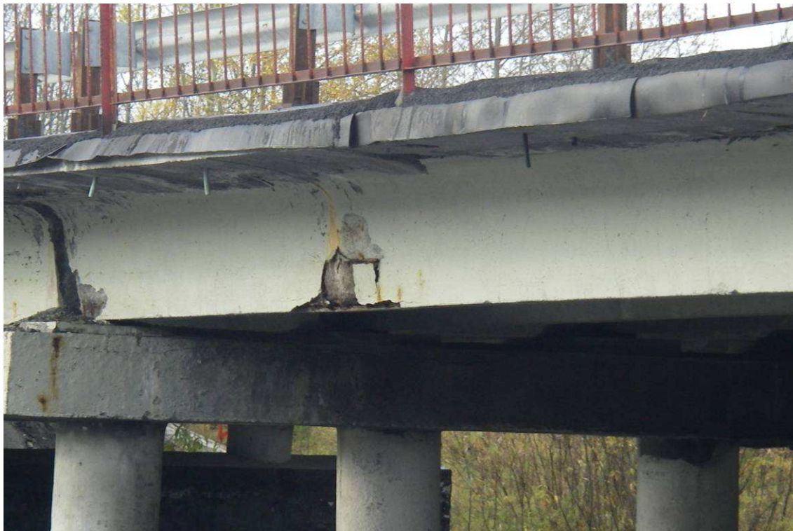
Рис. 27. Пролетное строение №3, балка №7. Разрушение защитного слоя бетона ребра балки с оголением арматурного каркаса и его коррозией
