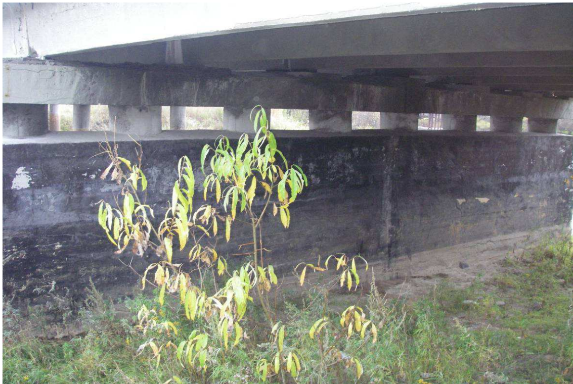
Рис. 19. Общий вид опоры №2. Шелушение обмазочной гидроизоляции бетонной поверхности опоры
