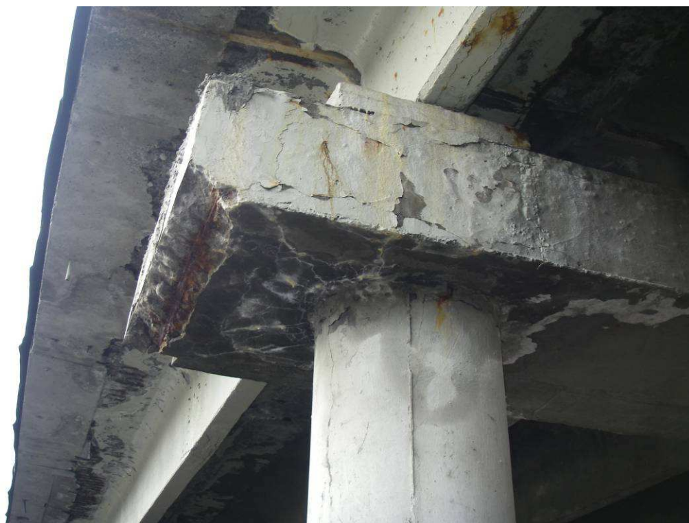
Рис. 28. Насадка опоры №4, правая сторона. Разрушение защитного слоя бетона блока насадки с оголением арматурного каркаса и его коррозией
