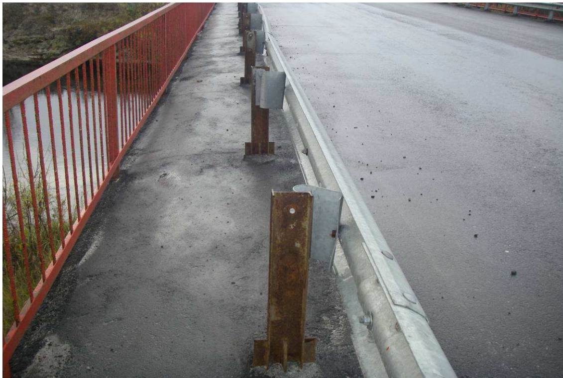
Рис. 11. Пролетное строение №3, правая сторона. Механические повреждения компенсаторов жесткости в конструкции ограждения безопасности
