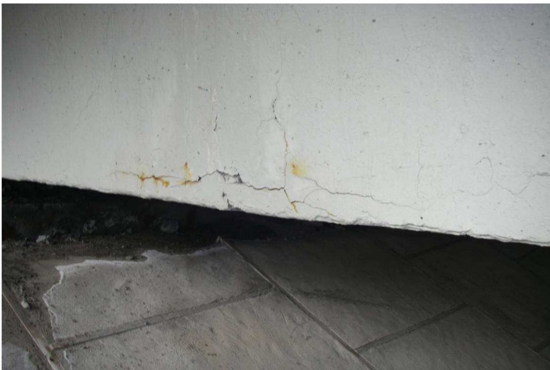
Рис. 14. Пролетное строение №1, балка №7. Трещина в ребре балки вдоль арматурного каркаса в растянутой зоне
