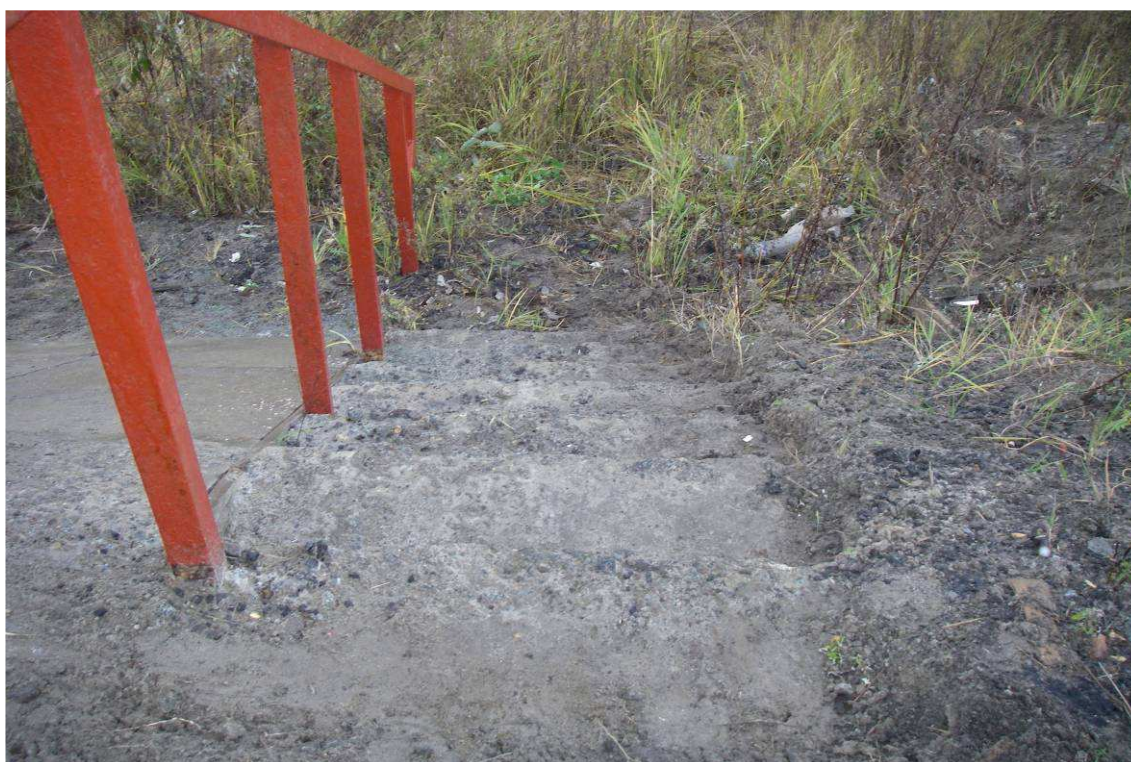
Рис. 40. Конец моста, левая сторона. Отсутствие заполнения перильного ограждения
