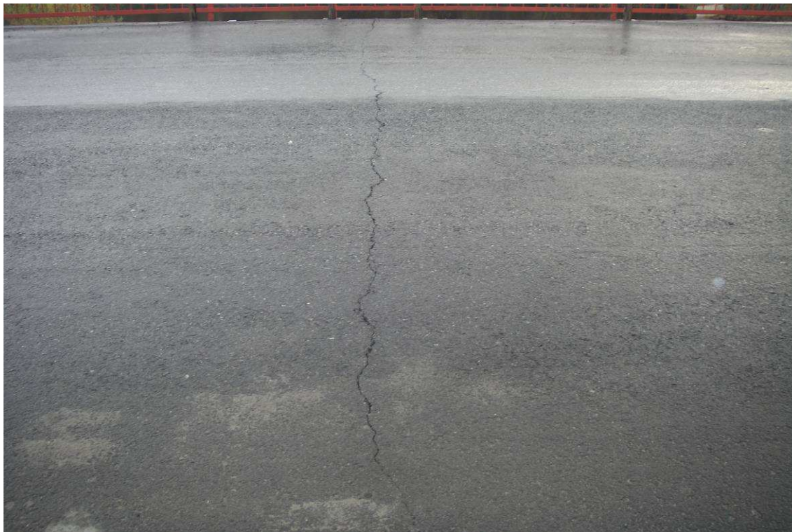
Рис. 7. Покрытие проезжей части над опорой №3. Поперечная трещина в покрытии проезжей части по всей ширине моста
