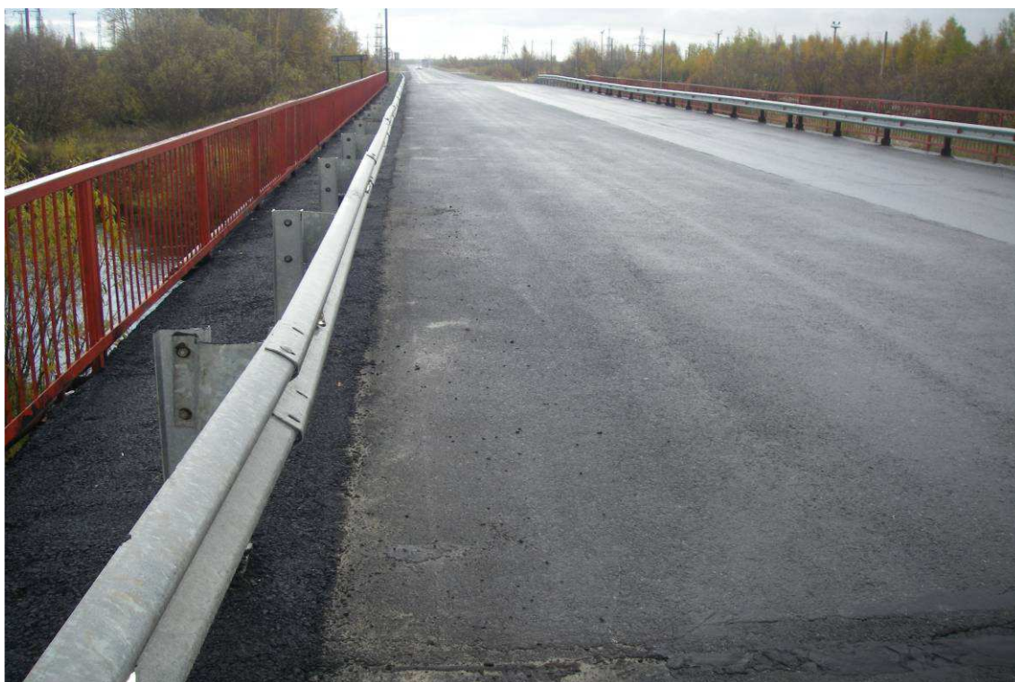
Рис. 4. Начало моста, левая сторона. Конструкция и схема установки ограждения безопасности не соответствует нормативным требованиям. Отсутствует разметка проезжей части моста
