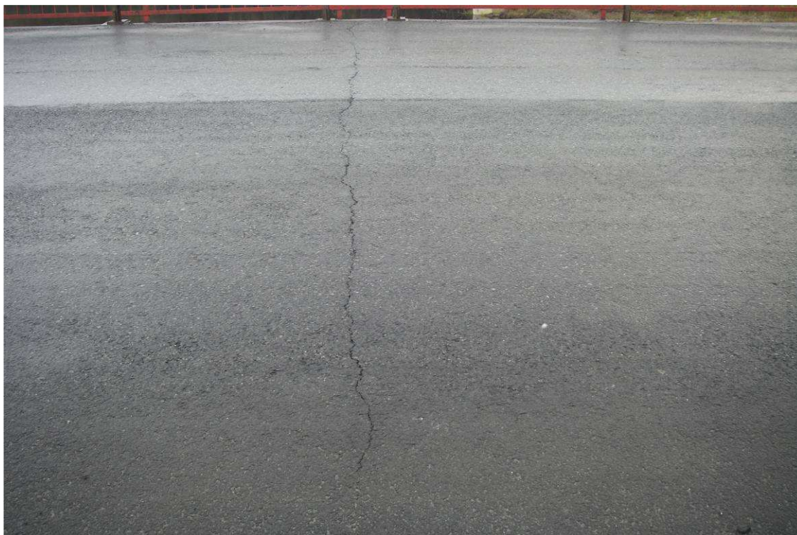
Рис. 6. Покрытие проезжей части над опорой №2. Поперечная трещина в покрытии проезжей части по всей ширине моста
