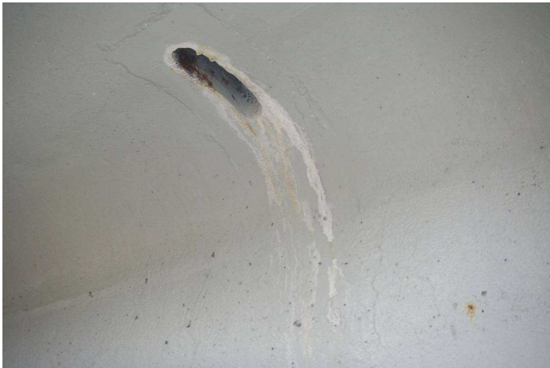
Рис. 15. Пролетное строение №1, балка №7. Строповочные отверстия не заделаны, образование щелочного налета
