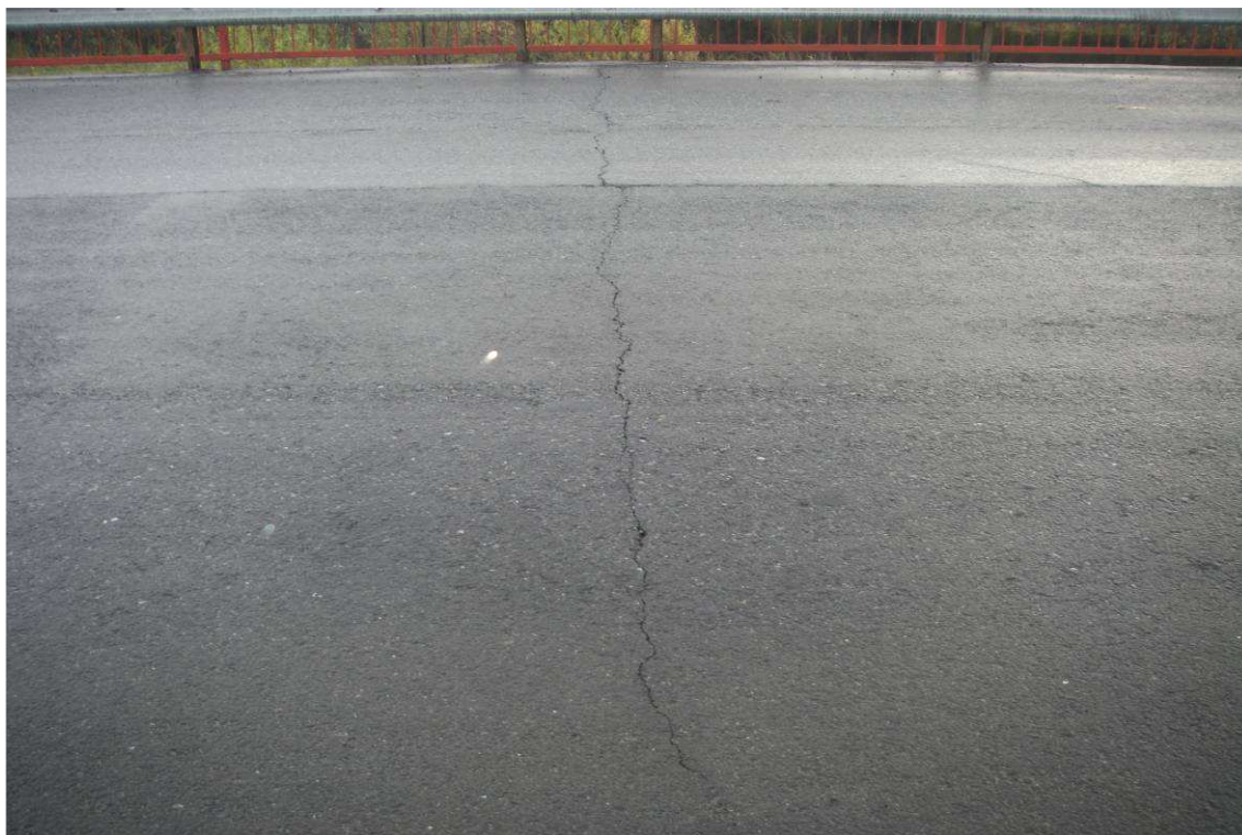
Рис. 8. Покрытие проезжей части над опорой №4. Поперечная трещина в покрытии проезжей части по всей ширине моста
