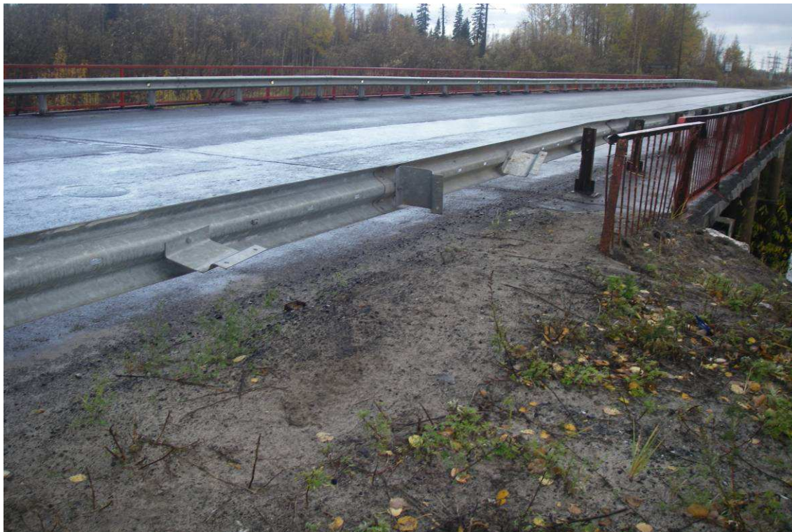
Рис. 9. Подход перед мостом справа. Отсутствие стоек в конструкции ограждения безопасности в зоне переходных плит
