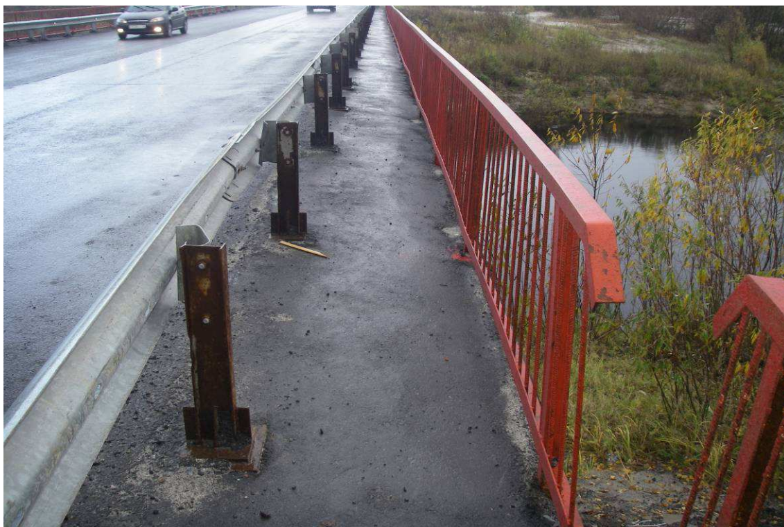
Рис. 3. Тротуар, правая сторона. Конструкция ограждения безопасности не соответствует нормативным требованиям, механические повреждения компенсаторов жесткости. Разрушение антикоррозийного покрытия металлической поверхности стоек ограждения безопасности с образованием поверхностной коррозии
