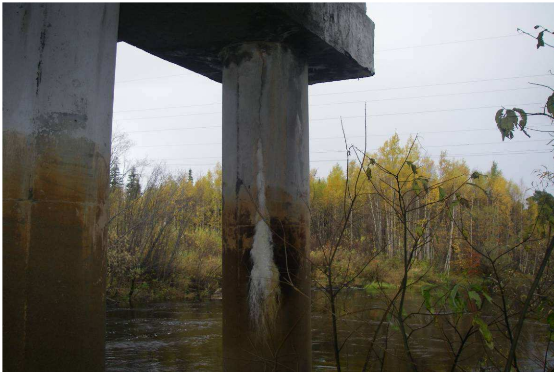
Рис. 29. Стойка №1, опоры №4. Вертикальная трещина на величину защитного слоя бетона с образованием щелочного налета
