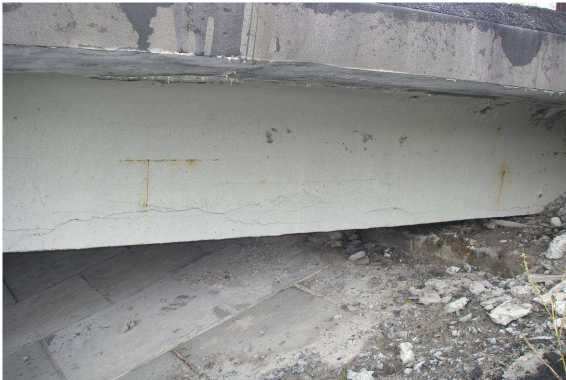
Рис. 33. Пролетное строение №5, балка №7. Поверхностные трещины в ребре балки, не превышающие толщину защитного слоя
