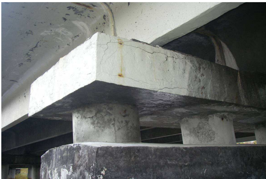
Рис. 20. Насадка опоры №2, левая сторона. Трещины в бетоне блока насадки на величину защитного слоя
