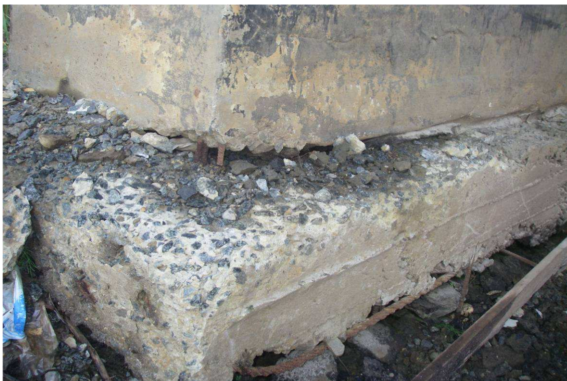
Рис. 22. Опора №2, правая сторона. Бетон ростверка и монолитной рубашки усиления опоры подвержен коррозии, арматура оголена
