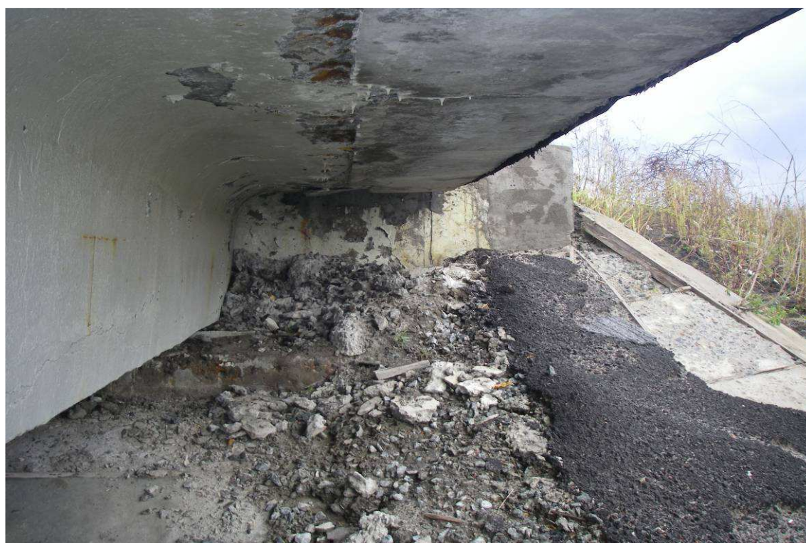
Рис. 36. Опора №6, правая сторона. Загрязнение горизонтальной поверхности насадки и подферменной площадки грунтом и обломками бетона
