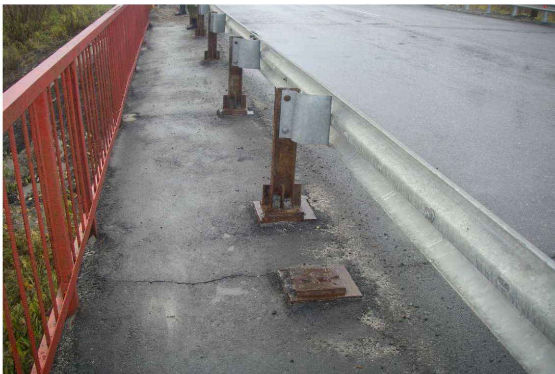
Рис. 12. Ограждение безопасности над опорой №5. Отсутствие стоки в конструкции ограждения безопасности
