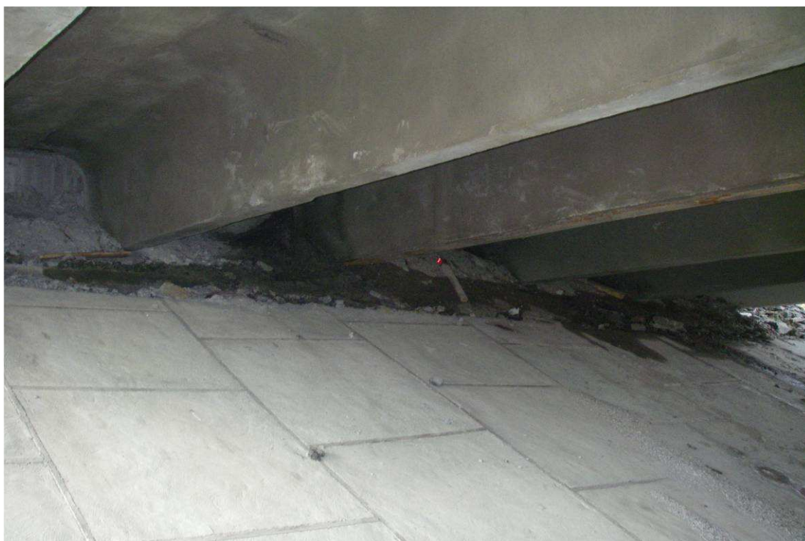
Рис. 16. Опора №1. Загрязнение горизонтальной поверхности насадки по всей длине, мокрые следы протечек через зазор ДШ
