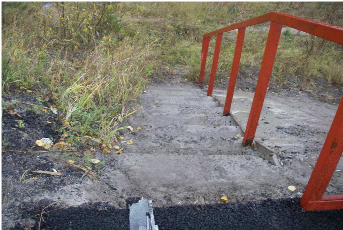
Рис. 39. Начало моста, левая сторона. Отсутствие заполнения перильного ограждения
