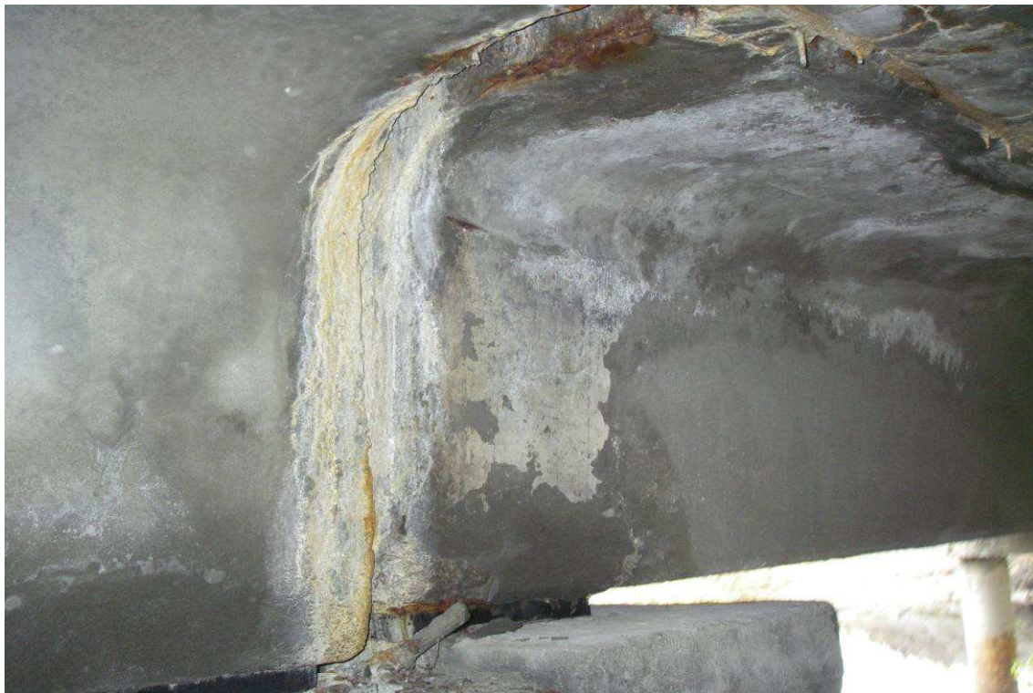
Рис. 31. Стык балок пролетного строения над опорой №5. Протечки через ДШ с образованием щелочного налета
