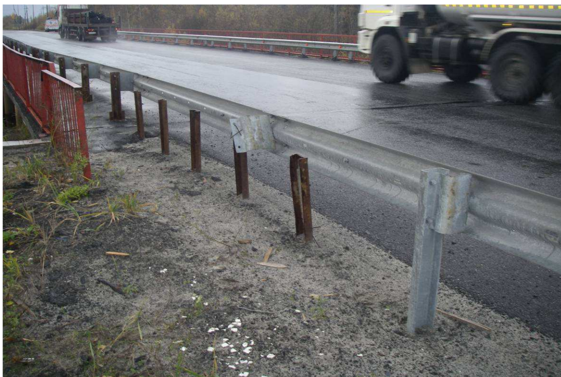
Рис. 10. Подход за мостом справа. Отсутствие компенсаторов жесткости в конструкции ограждения безопасности в зоне переходных плит
