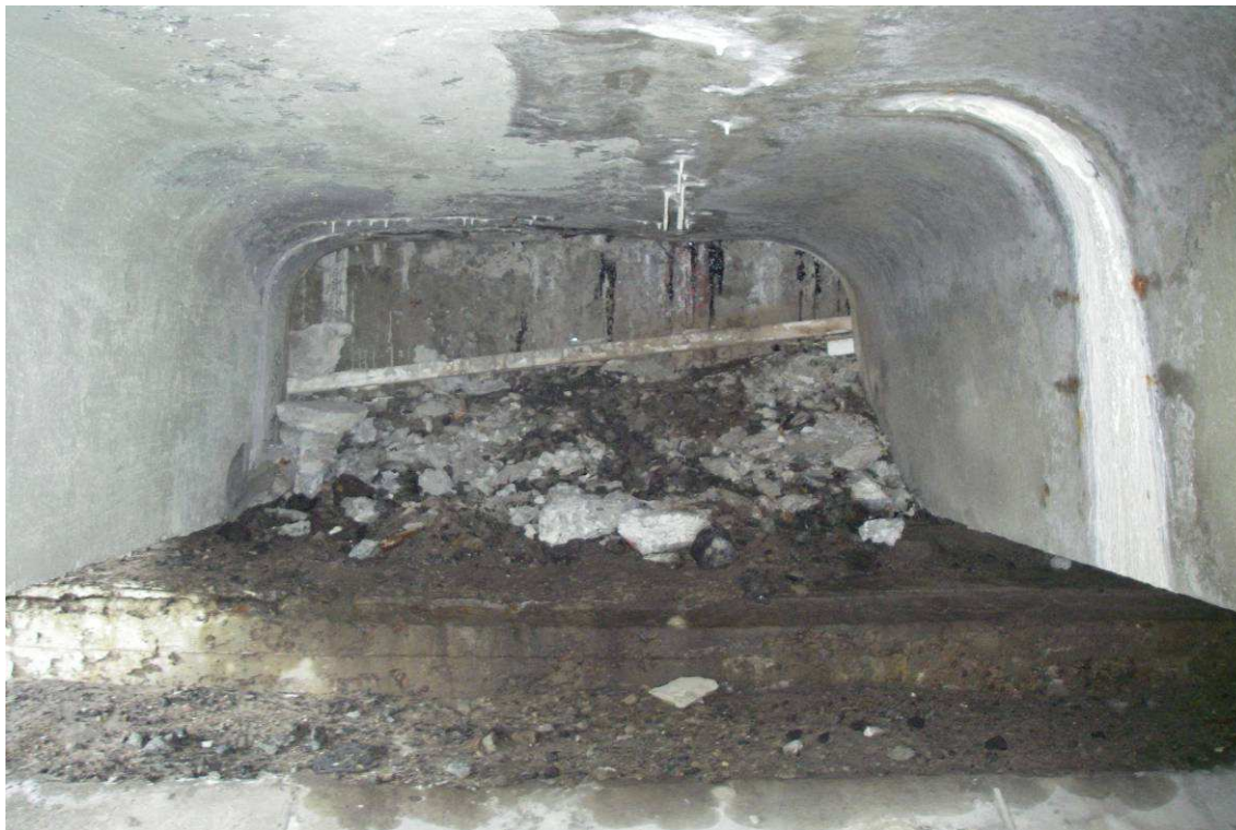
Рис. 37. Опора №6. Загрязнение горизонтальной поверхности насадки по всей длине, мокрые следы протечек через зазор ДШ, образование щелочного налета у строповочных отверстий
