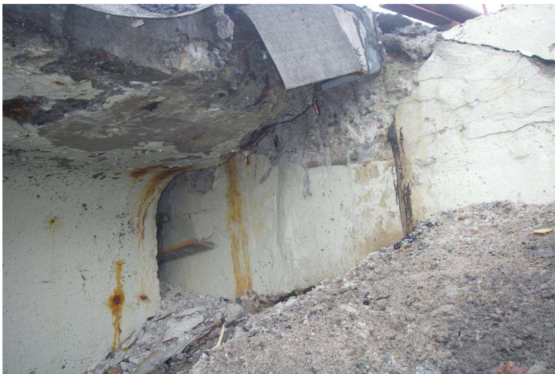
Рис. 17. Пролетное строение №1, балка №1. Разрушение защитного слоя бетона консоли балки с оголением арматурного каркаса
