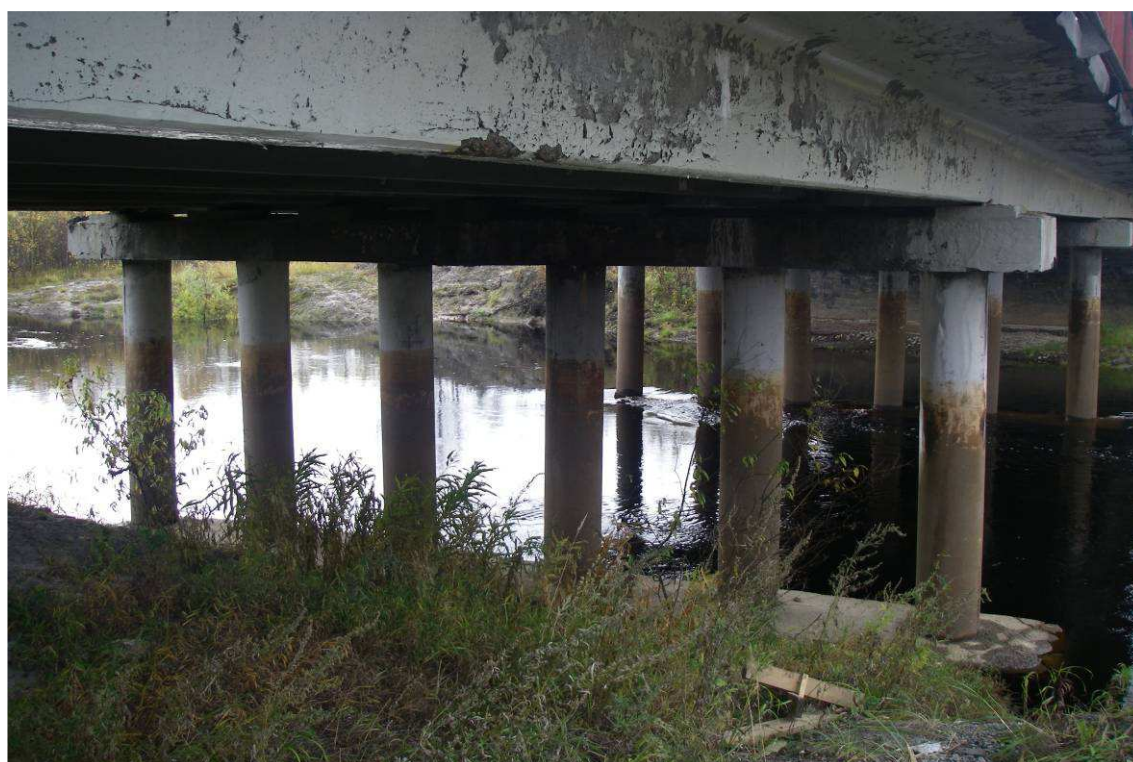
Рис. 26. Общий вид опоры №4 и балки №1 пролетного строения №4. Шелушение бетонной поверхности опоры и балки пролетного строения
