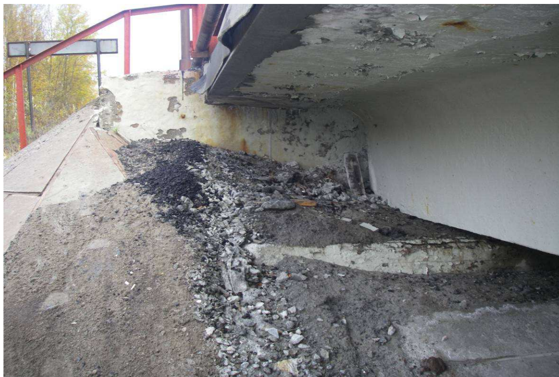
Рис. 35. Опора №6, левая сторона. Загрязнение горизонтальной поверхности насадки и подферменной площадки грунтом и обломками бетона
