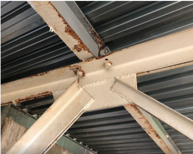
Рис.3.6 Болтовое соединение прогонов и верхних поясов ферм в местах опирания
