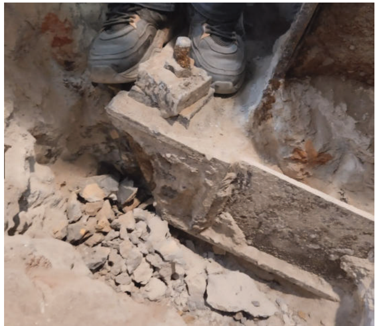
Рис.2.2 Вскрытие базы колонны К2
