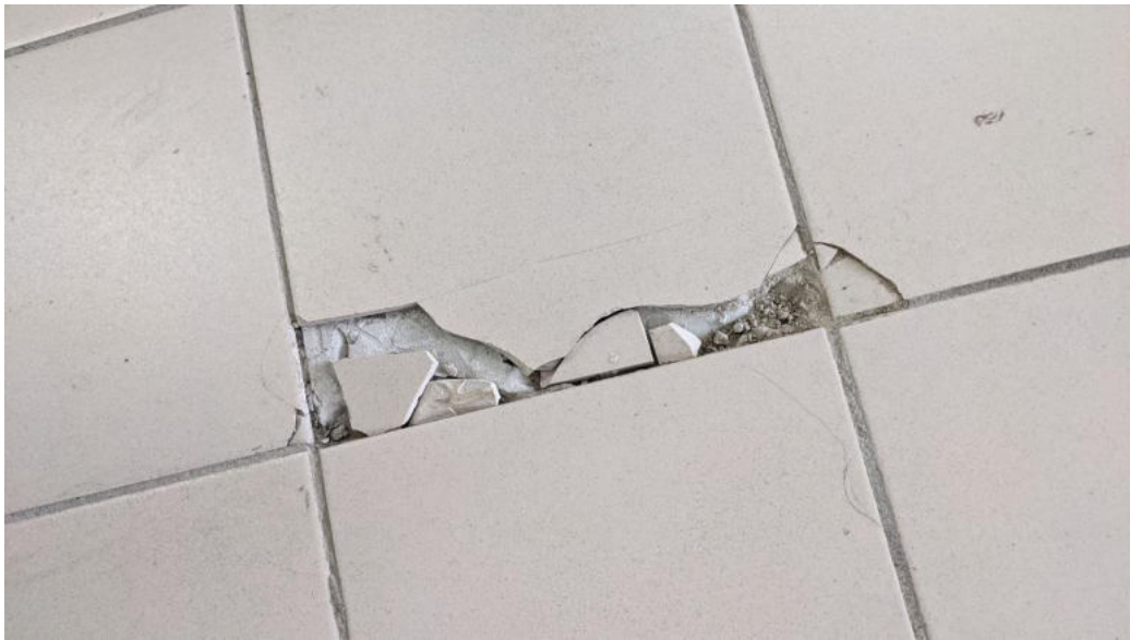
Фото 29. Помещение 338 в осях А-В/16-17. Разрушение локальное напольного покрытия
