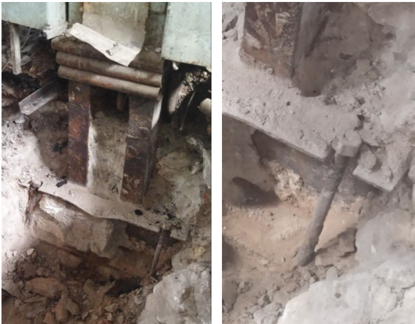
Рис.3.2 Вскрытие базы колонны К1
