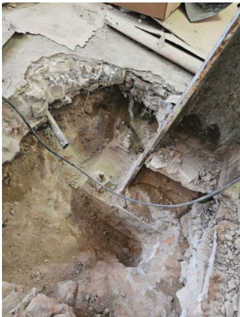
Рис.2.2 Вскрытие базы колонны К2
