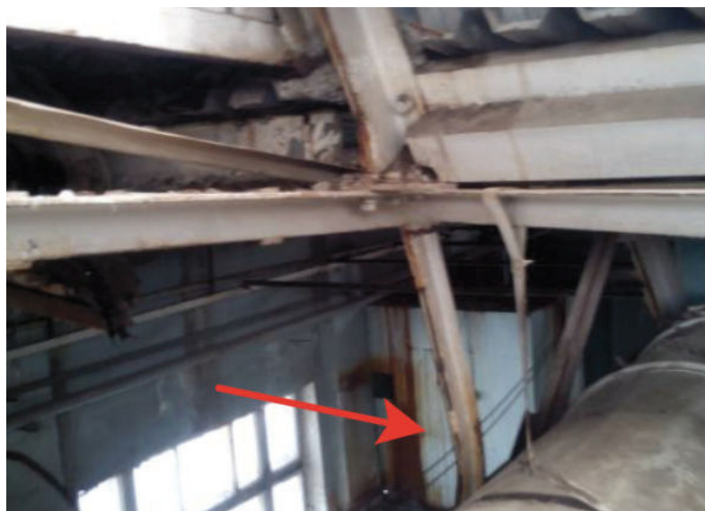
Рис.7.2 Выход из плоскости стойки фермы Ф-2
