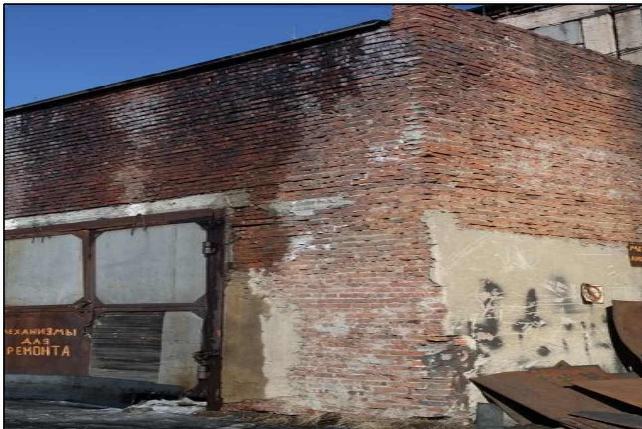
Фотография 3.10. (Разрушение блоков стенового ограждения в осях 31-32/А)
