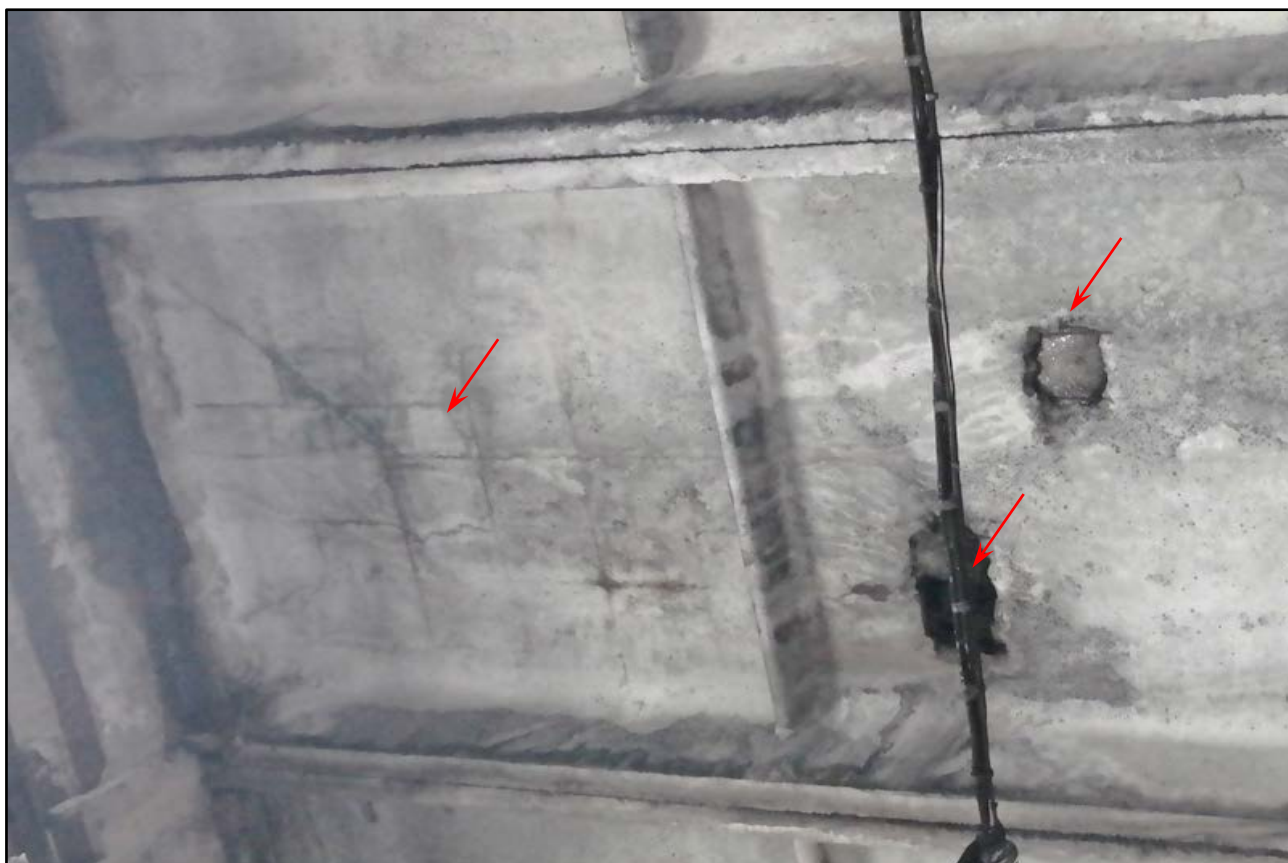
Фотография 3.36. (В полке плиты покрытия по рабочей арматурной сетке образовались трещины. В полке плиты пробиты и не заделаны отверстия в осях 20-21/А-Б)
