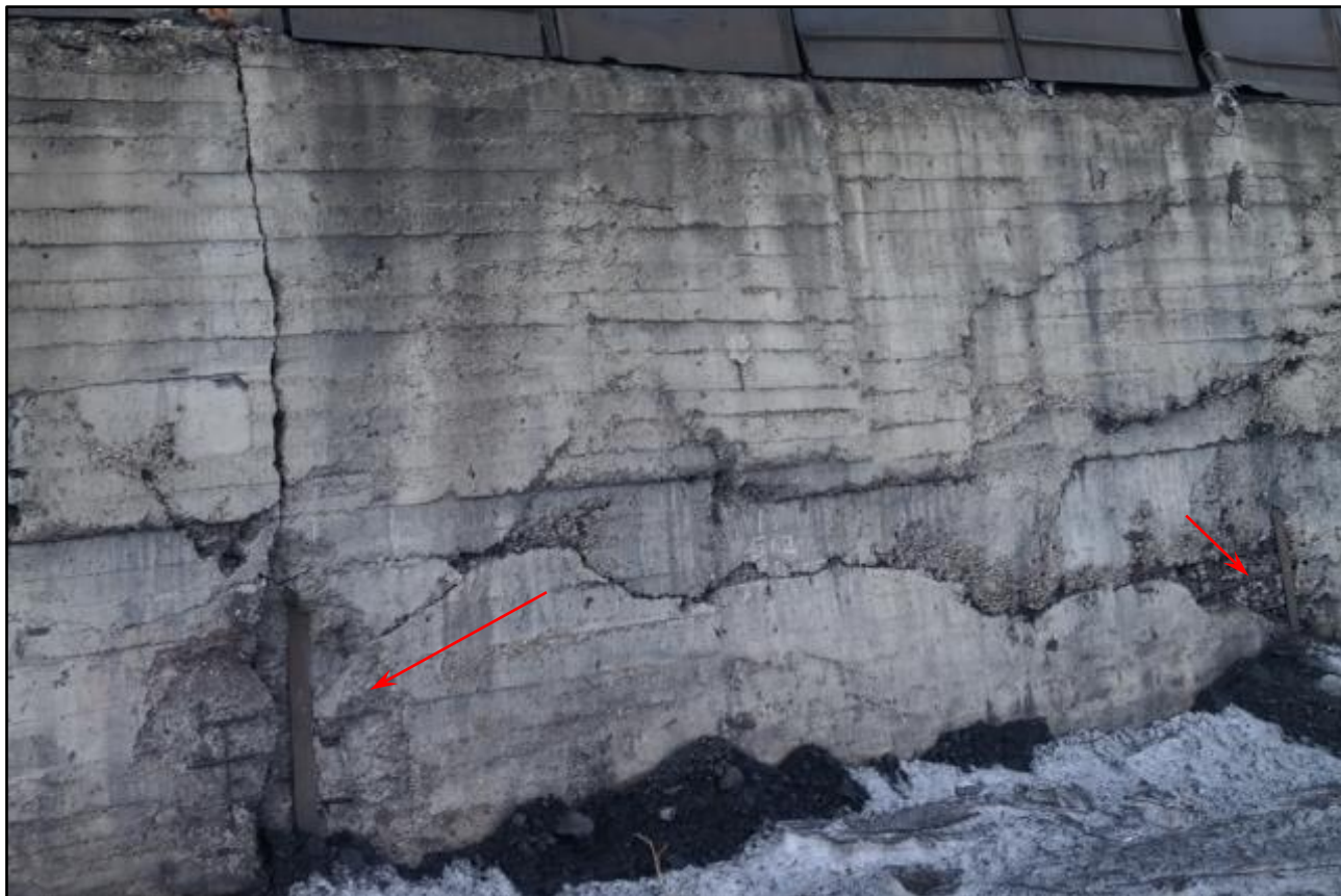
Фотография 3.19. (Разрушение раствора заделки швов между стеновыми блоками в осях 26-28/А)
