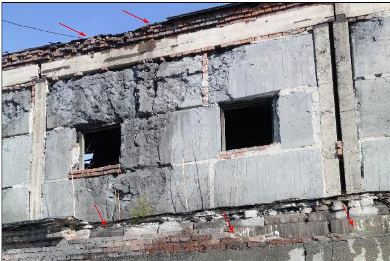
Фотография 3.8. (Замачивание и следы замачивания кирпичной кладки стен осях 40/А-Б/2)
