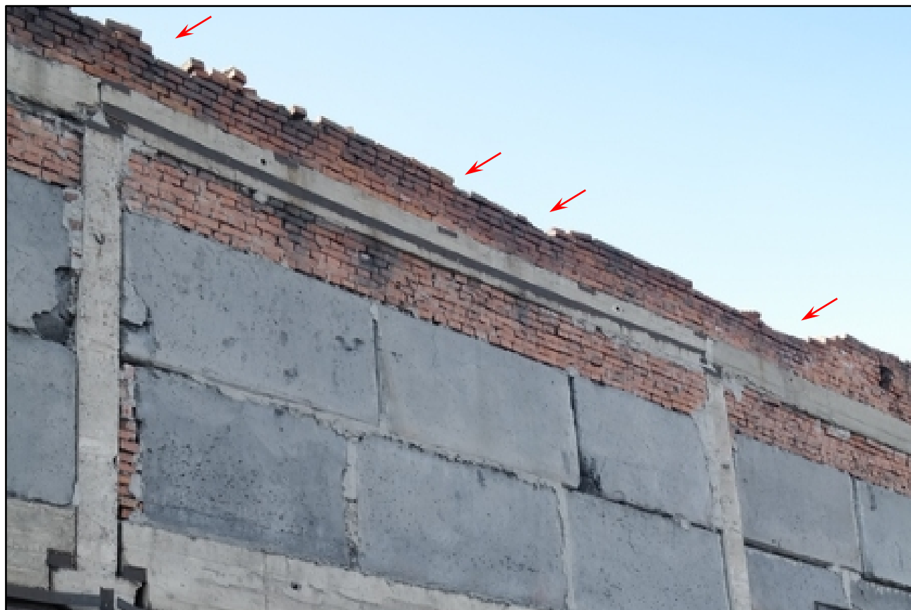
Фотография 3.4. (Разрушение кирпичной кладки на глубину до 250 мм в осях 12-13/А)
