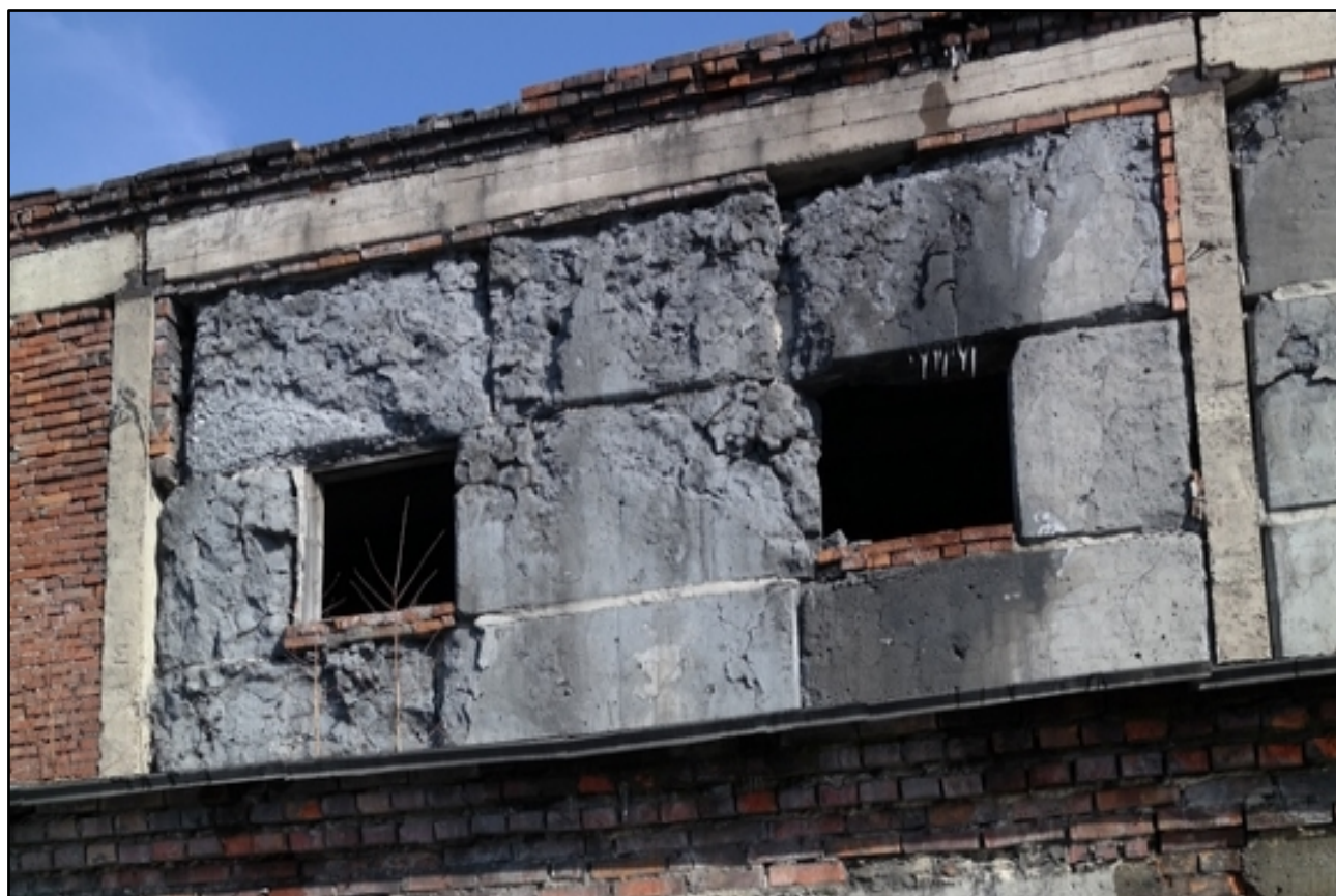
Фотография 3.14. (Разрушение блоков стенового ограждения. Отслаивания защитного слоя, трещины, сколы в осях 30-29/Б)
