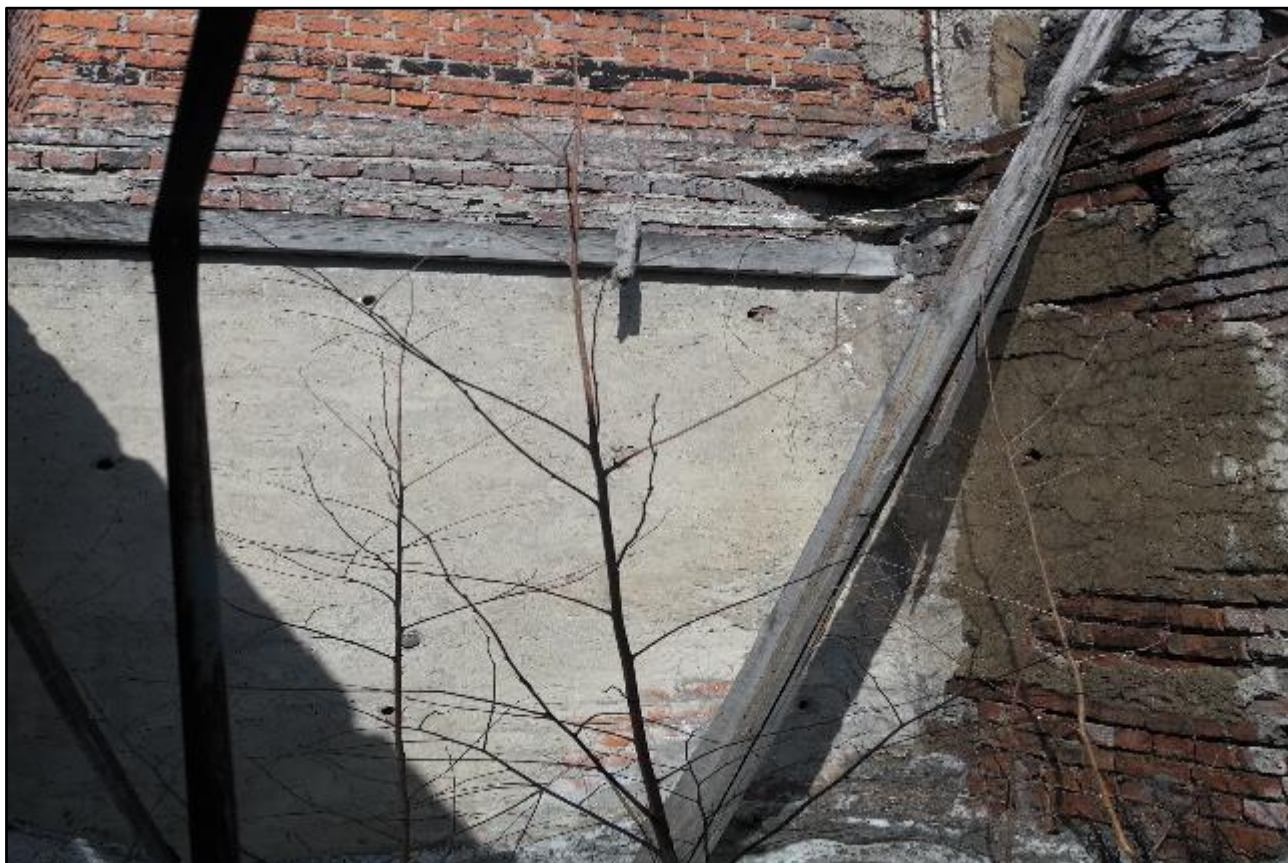
Фотография 3.38. (Отсутствуют плиты покрытия пристройки в осях 38-39/Б/2-Б)
