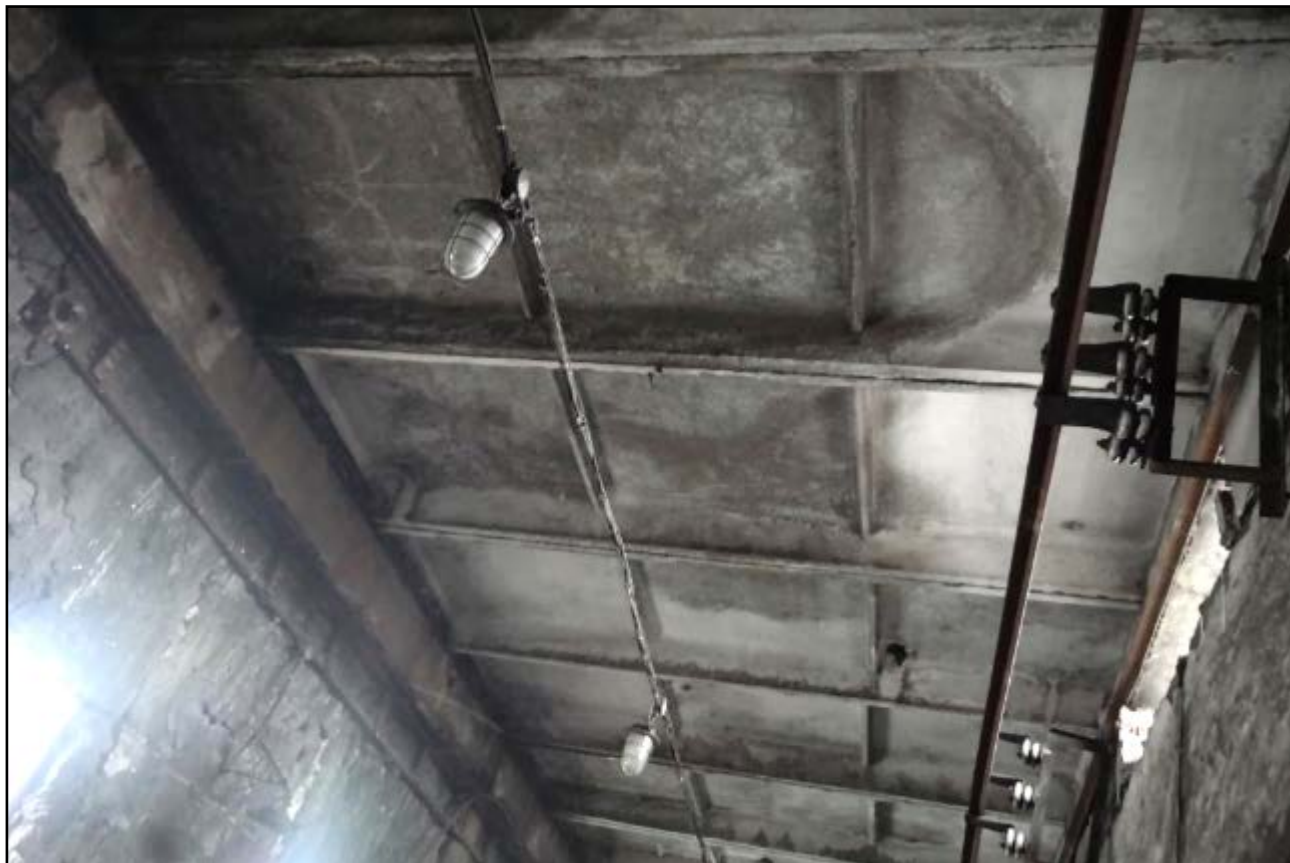
Фотография 3.34. (Разрушение защитного слоя бетона монолитного участка покрытия оголена и корродирована арматура, на поверхности плиты видны следы замачивания в осях 29-30/А-Б)
