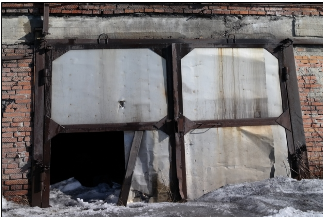
Фотография 3.27. (Физический износ ворот в осях 35-34/Б/1)
