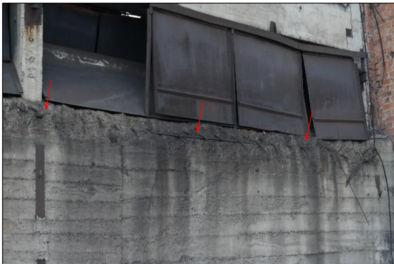
Фотография 3.16. (Разрушение бетона верха монолитной стены, оголена и корродирована арматура в осях 38-39/А)
