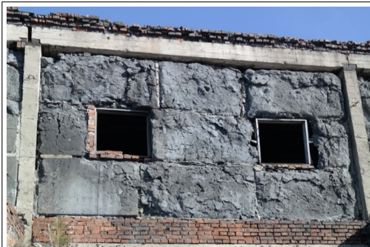
Фотография 3.14. (Разрушение блоков стенового ограждения. Отслаивания защитного слоя, трещины, сколы в осях 30-29/Б)
