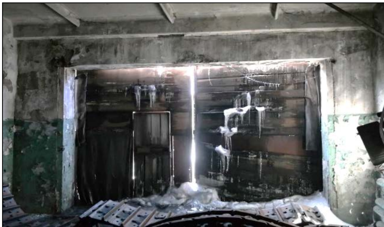
Фотография 3.31. (Разрушение отделочного покрытия стен. Замачивание внутренней поверхности стен в осях 35-36/Б/2)
