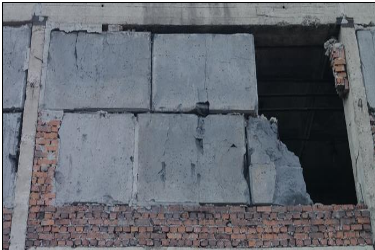
Фотография 3.10. (Разрушение блоков стенового ограждения в осях 31-32/А)
