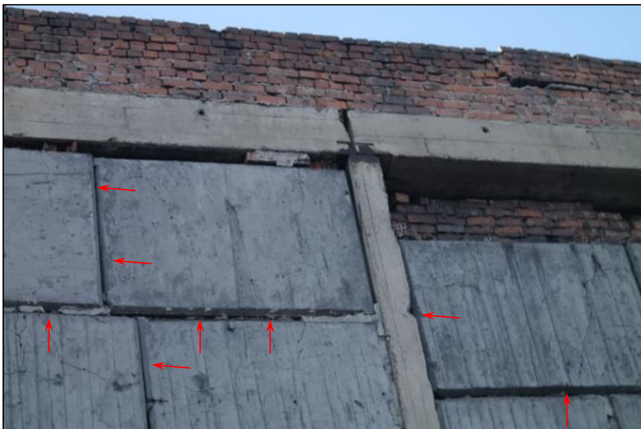
Фотография 3.19. (Разрушение раствора заделки швов между стеновыми блоками в осях 26-28/А)
