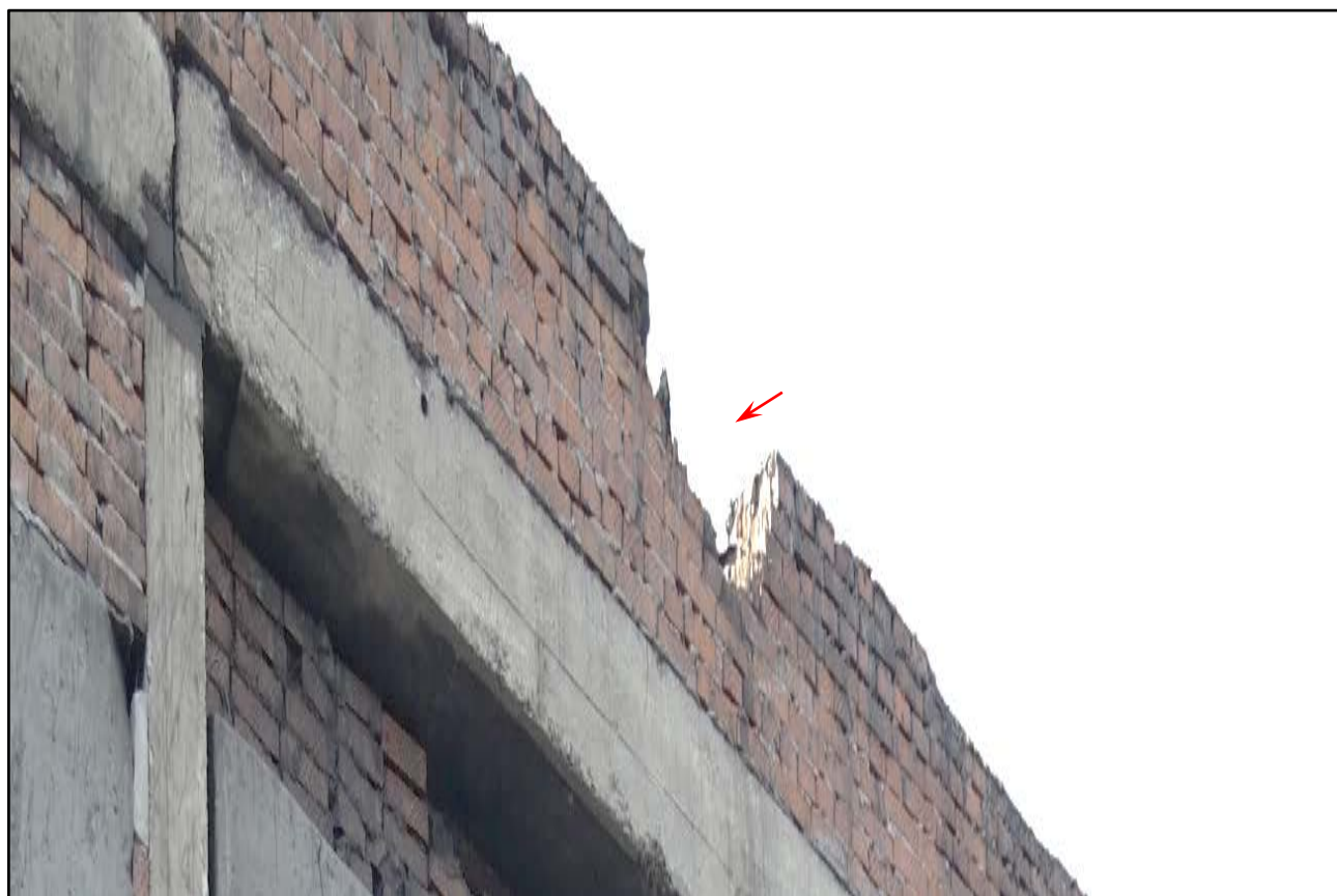
Фотография 3.4. (Разрушение кирпичной кладки на глубину до 250 мм в осях 12-13/А)
