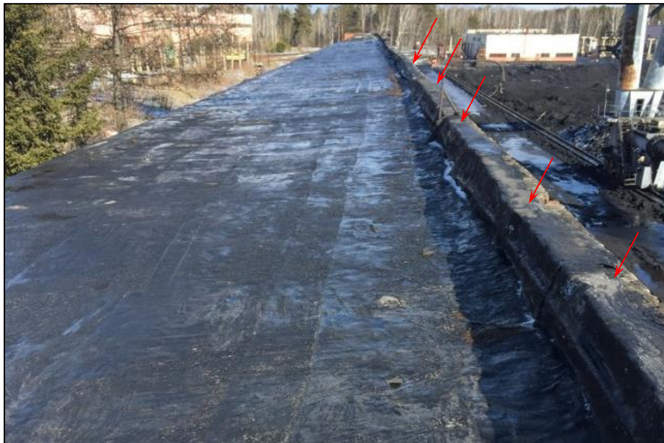
Фотография 3.39. (Разрушен кровельного ковра. Отсутствуют защитные фартуки из оцинкованной стали на парапетной стене в осях 3-39/А-Б)
