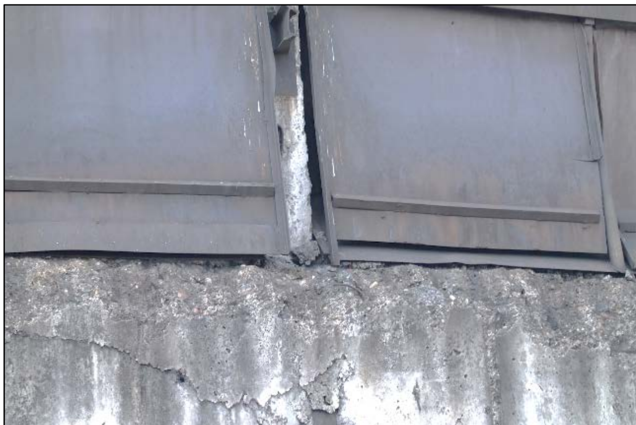
Фотография 3.16. (Разрушение бетона верха монолитной стены, оголена и корродирована арматура в осях 38-39/А)
