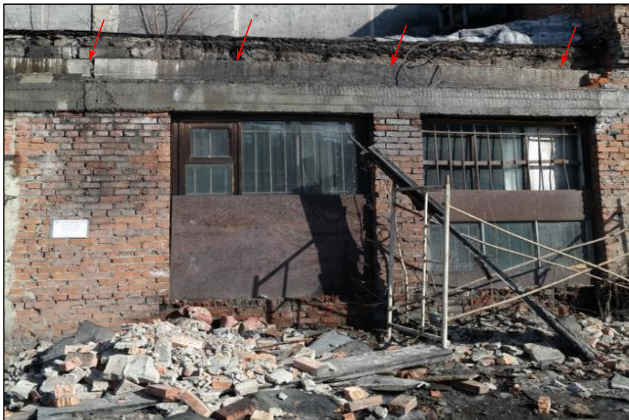
Фотография 3.6. (Разрушение кирпичной кладки на глубину до 150 мм 24-23/Б)
