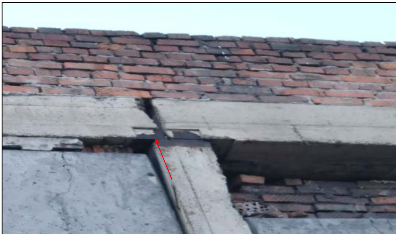
Фотография 3.23. (Вертикальные трещины в ригеле шириной раскрытия 3-6 мм в осях 22-23/А)
