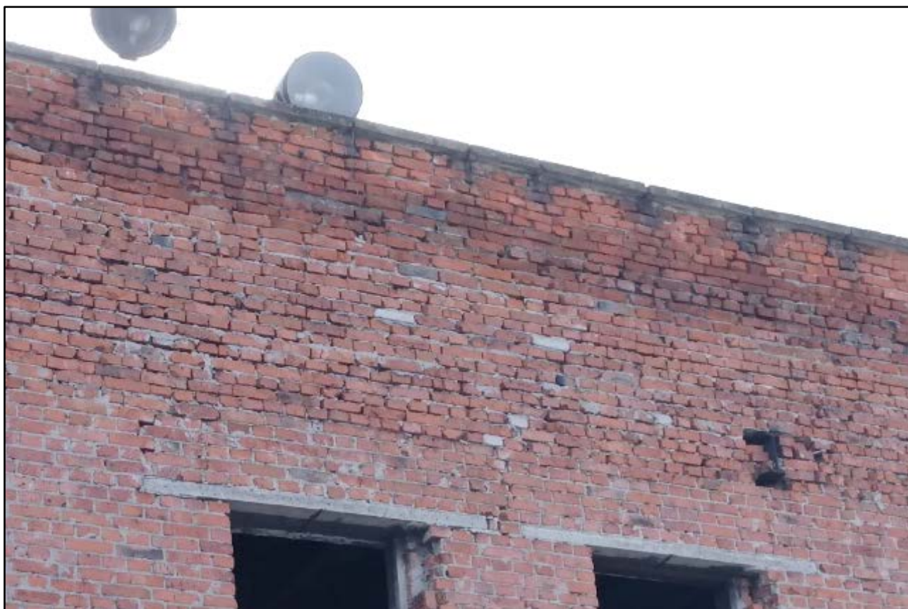
Фотография 3.8. (Замачивание и следы замачивания кирпичной кладки стен осях 40/А-Б/2)
