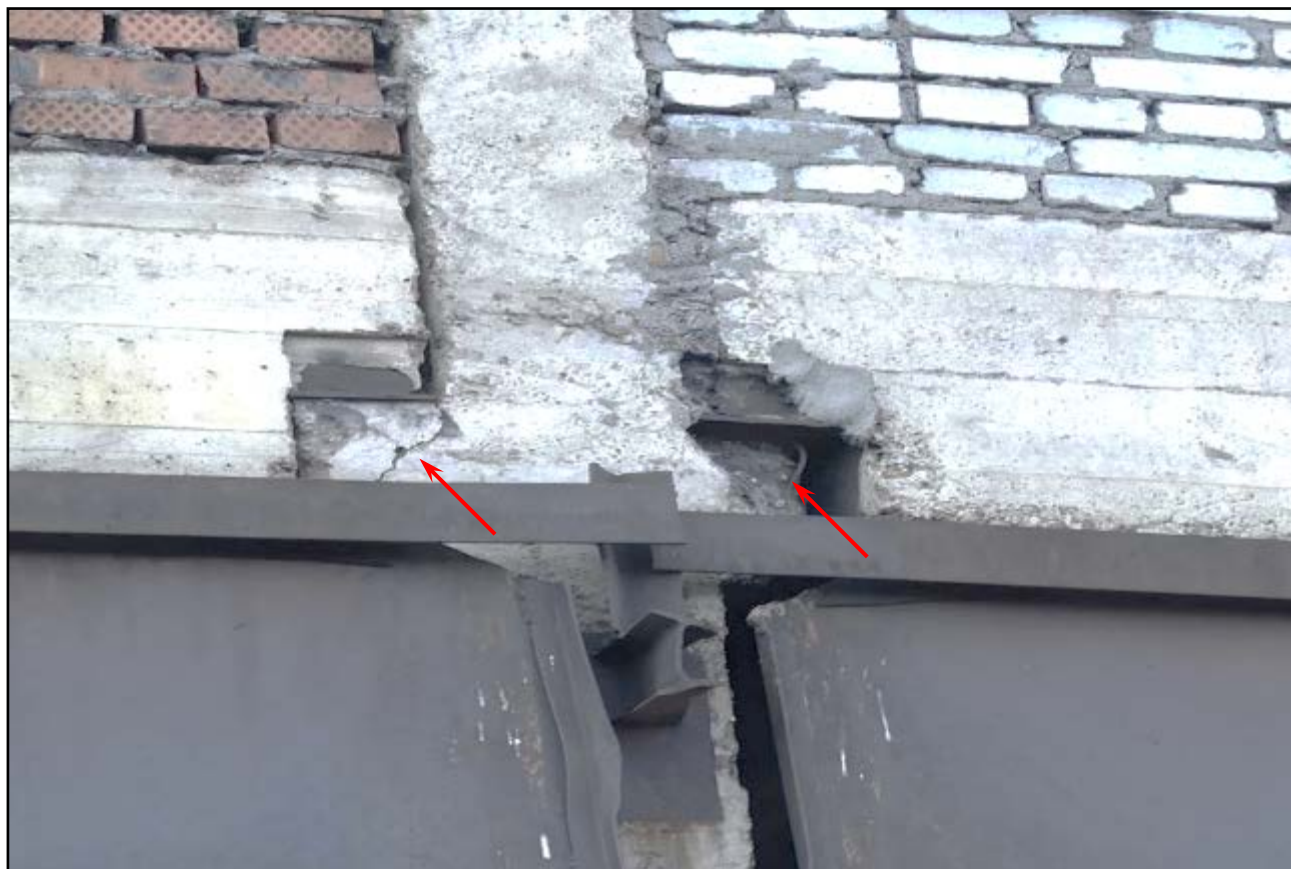
Фотография 3.20. (Разрушение бетона консоли колонны, оголена арматура. Трещина в консоли колонны в осях 20/А)
