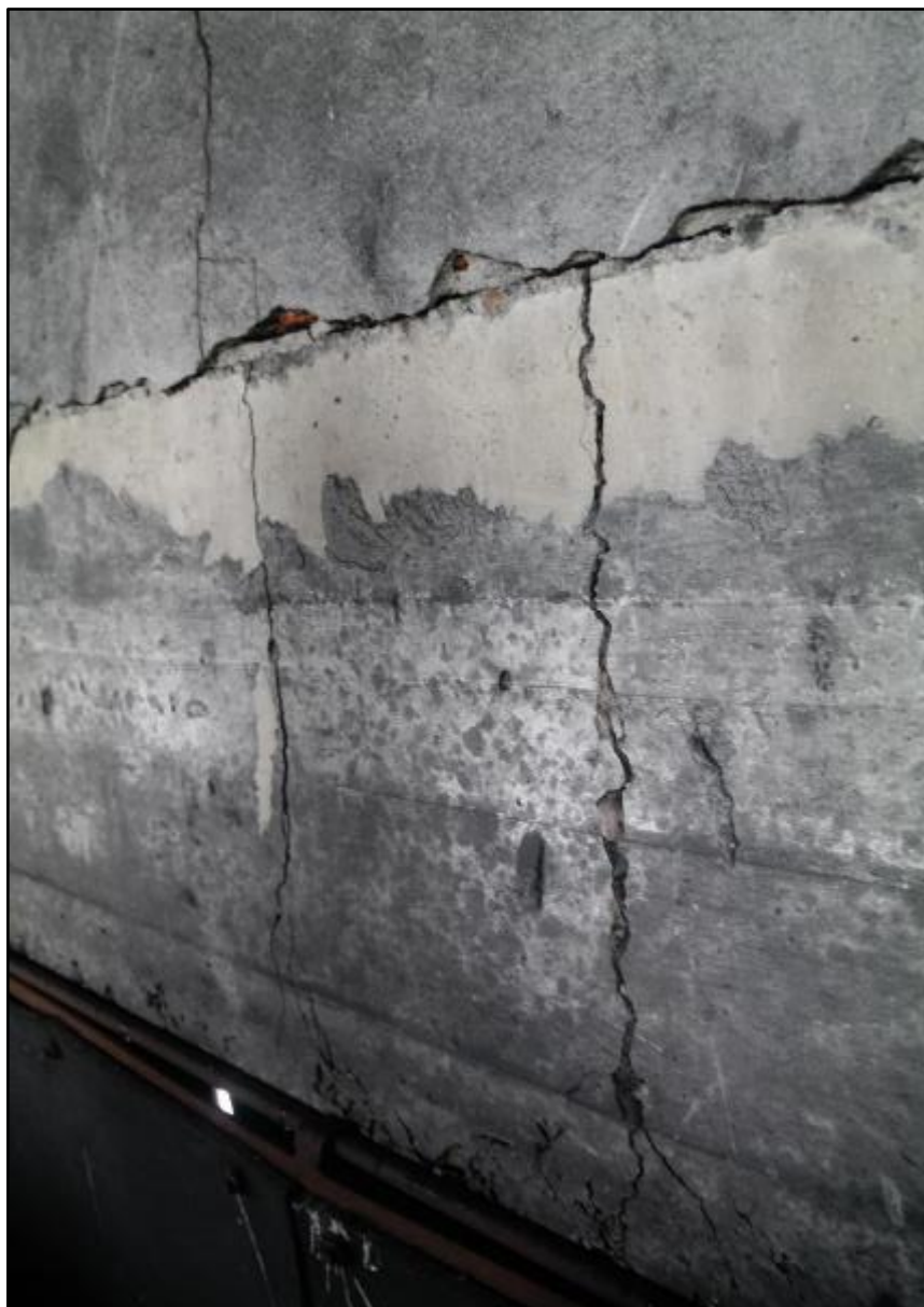
Фотография 3.25. (Вертикальные трещины в ригеле шириной раскрытия 3-10 мм в осях 35-34/А)
