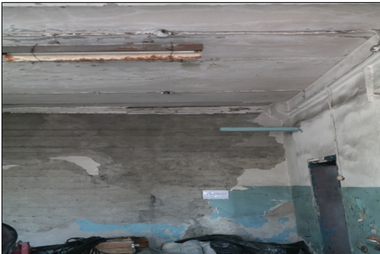
Фотография 3.31. (Разрушение отделочного покрытия стен. Замачивание внутренней поверхности стен в осях 35-36/Б/2)
