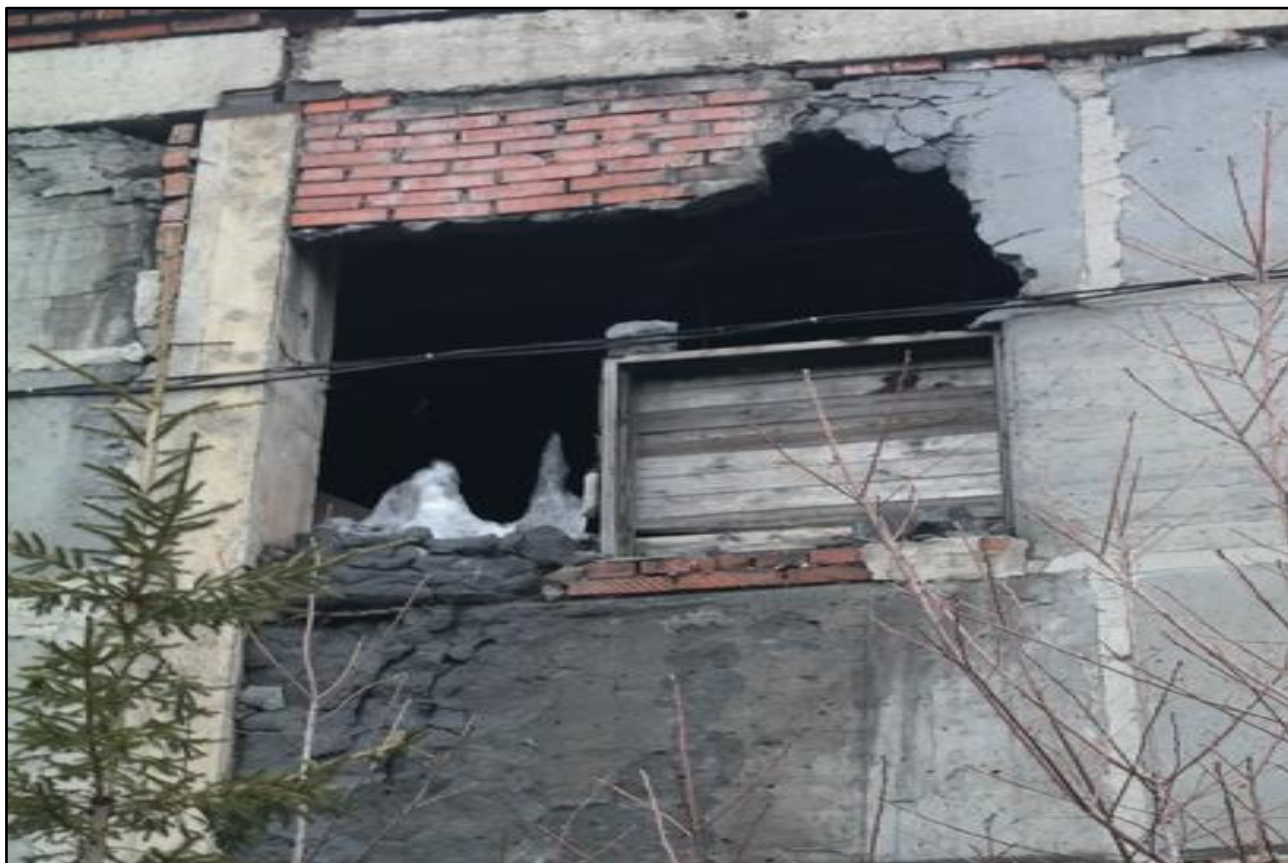
Фотография 3.12. (Разрушение блоков стенового ограждения в осях 6-5/Б)
