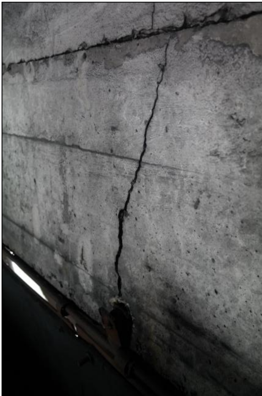
Фотография 3.24. (Вертикальная трещина в ригеле шириной раскрытия 8 мм в осях 31-32/А)
