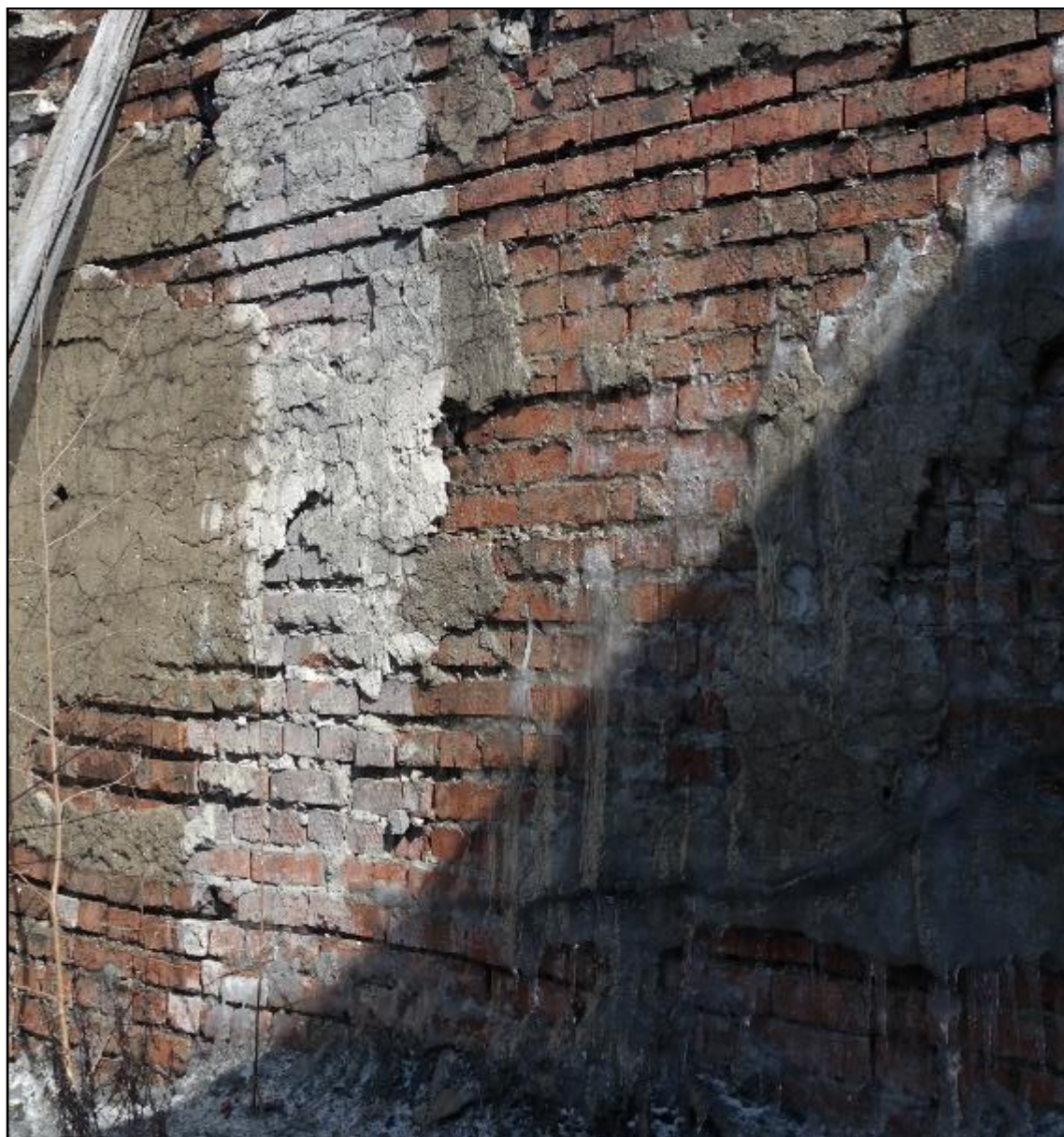
Фотография 3.32. (Замачивание кирпичной кладки в осях 39-38/Б)
