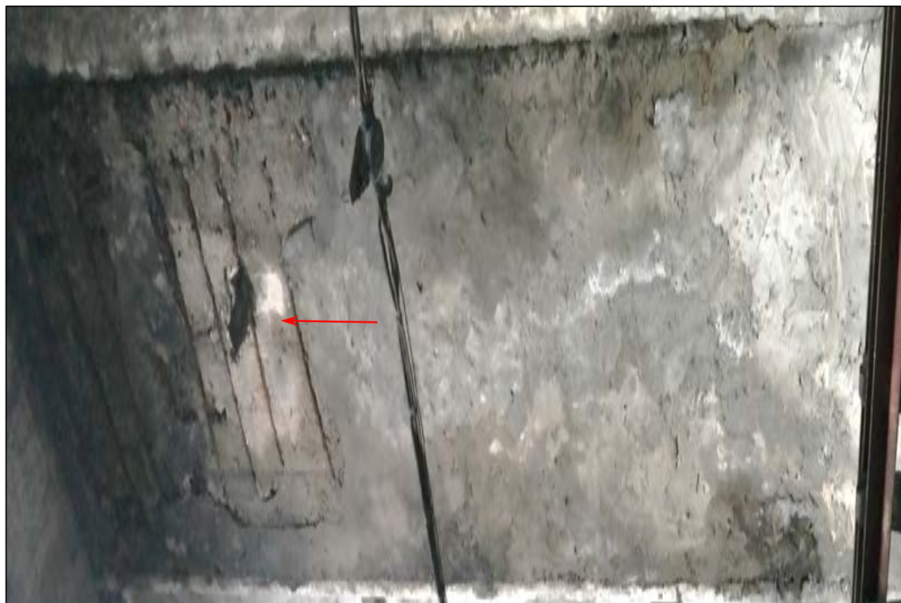
Фотография 3.34. (Разрушение защитного слоя бетона монолитного участка покрытия оголена и корродирована арматура, на поверхности плиты видны следы замачивания в осях 29-30/А-Б)
