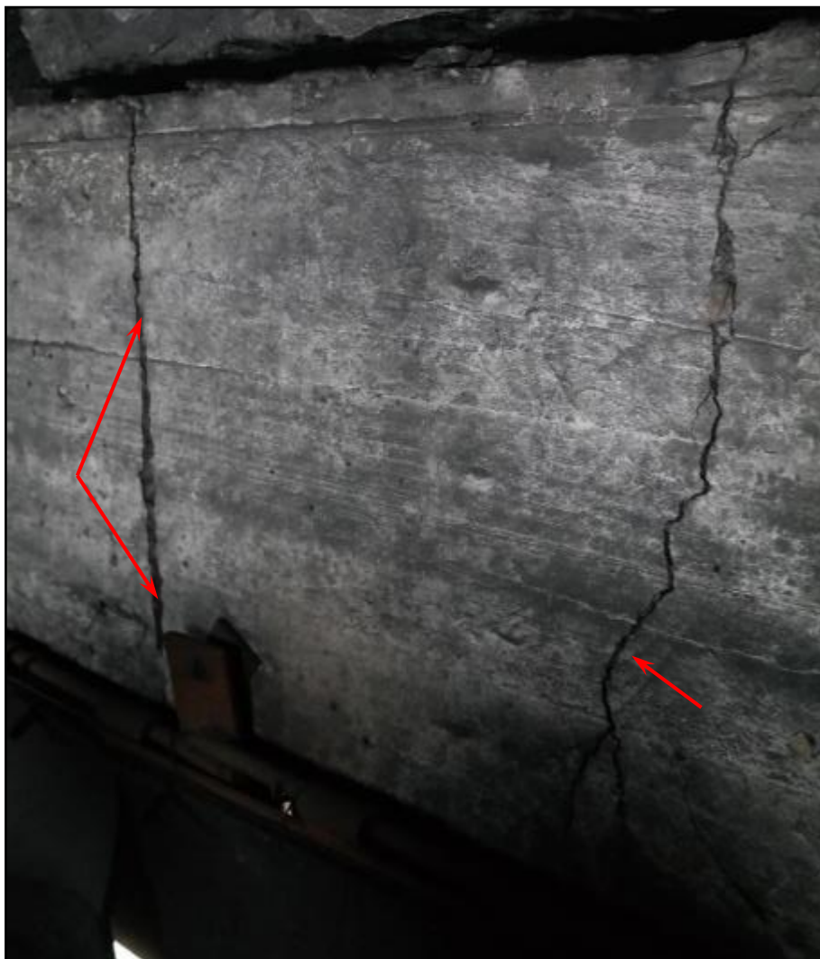
Фотография 3.23. (Вертикальные трещины в ригеле шириной раскрытия 3-6 мм в осях 22-23/А)
