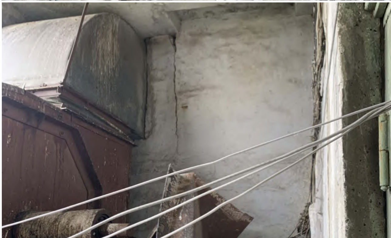
Фото П2.17÷П.2.18. Наклонные и вертикальные трещины в наружных и внутренних стеновых панелях в осях 1-10 / А-К с шириной раскрытия до 4 мм.
