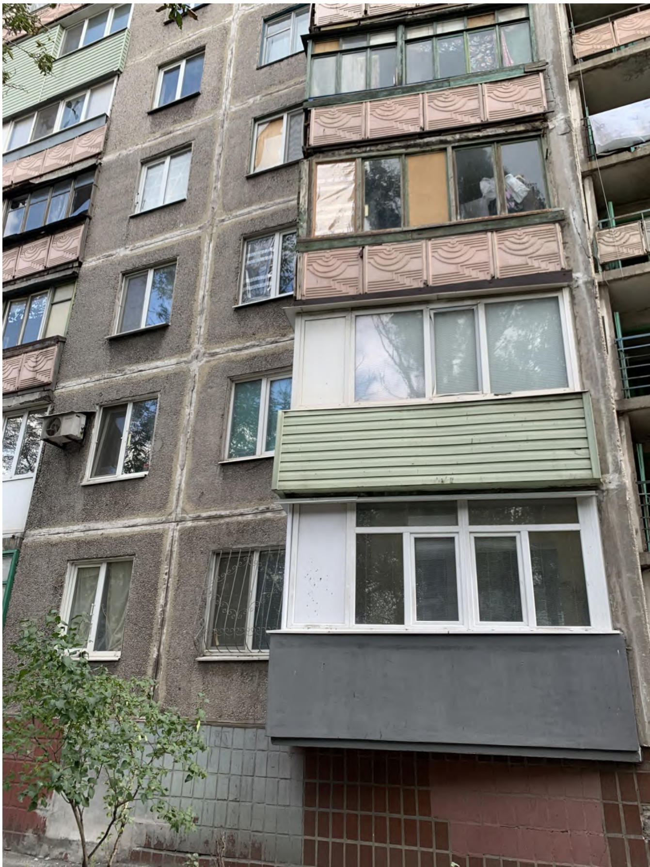
Фото П2.23. Разрушение заполнения (выпадение раствора, наличие трещин в швах) горизонтальных и вертикальных швов между стыками стеновых панелей.
