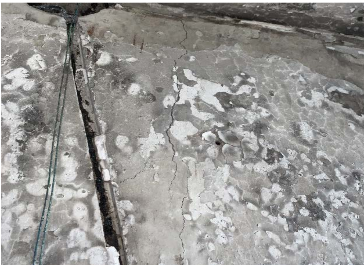
Фото П2.11÷П.2.12. Не многочисленные наклонные и вертикальные, трещины в наружных и внутренних стеновых панелях в уровне 4-11 этажей в осях 1-10 / А-К с шириной раскрытия до 4 мм.
