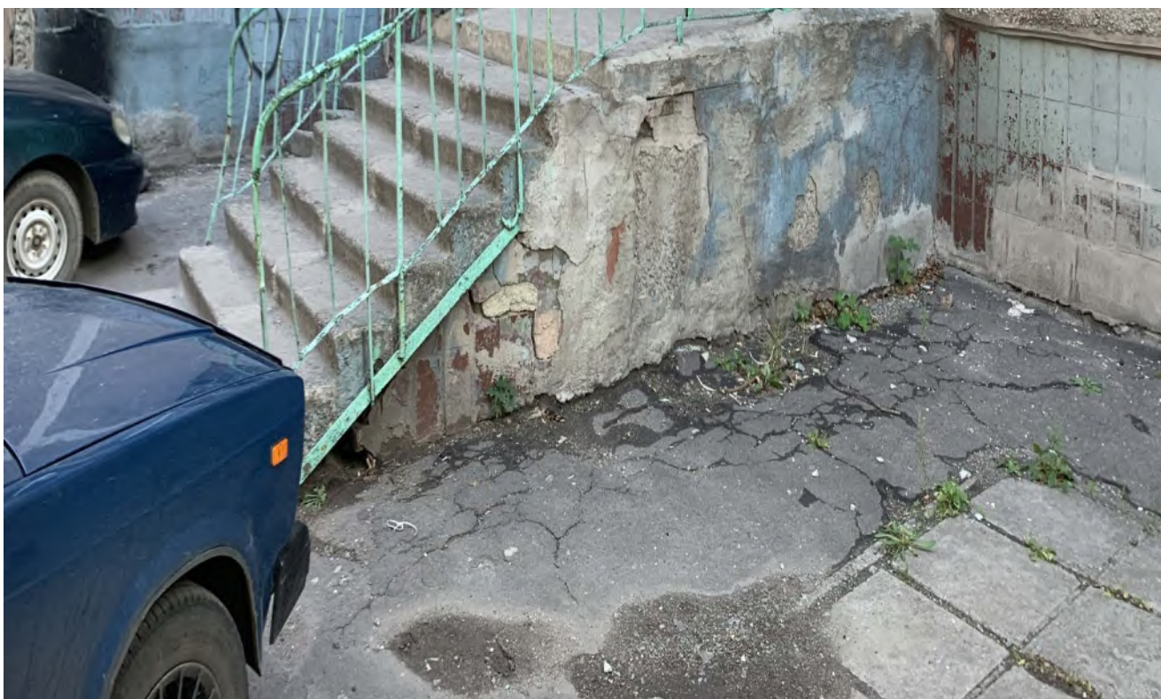
Фото П2.9÷П.2.10. Многочисленные трещины, разрушения и частичное отсутствие отмостки, прорастание растительности через отмостку. Зазор в месте примыкания отмостки к цоколю здания.
