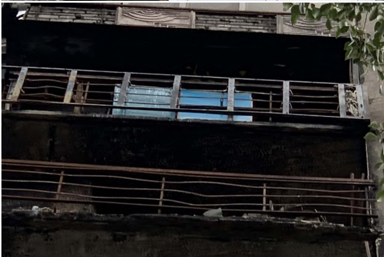
Фото П2.19÷П.2.20. Повреждение стеновых панелей (сажа и копоть, отслоение поверхностного фактурного слоя бетона) вследствие пожара.
