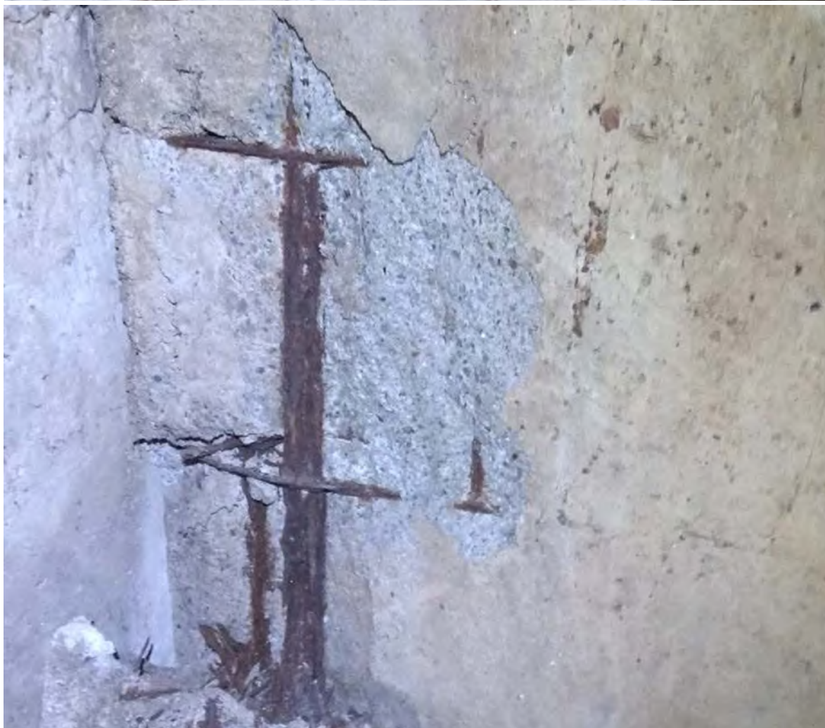
Фото П2.25÷П.2.26. Разрушение защитного слоя бетона, сколы, трещины, оголение и коррозия арматуры перекрытий местами утрата сечения арматурных стержней (до 3 мм) в уровне подвала.
