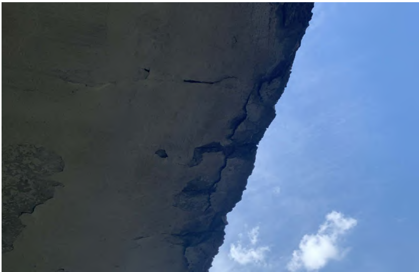
Фото П2.27÷П.2.28. Отслоение окрасочного покрытия, коррозия ограждений балконов, разрушение защитного слоя бетона с оголением и коррозией рабочей арматуры балконных плит.
