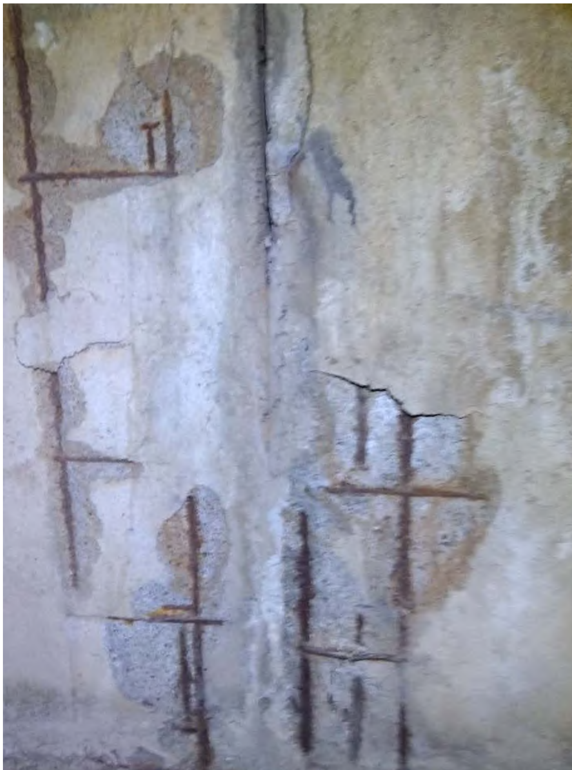
Фото П.2.24. Разрушение защитного слоя бетона, сколы, трещины, оголение и коррозия арматуры перекрытий местами утрата сечения арматурных стержней (до 3 мм) в уровне подвала.
