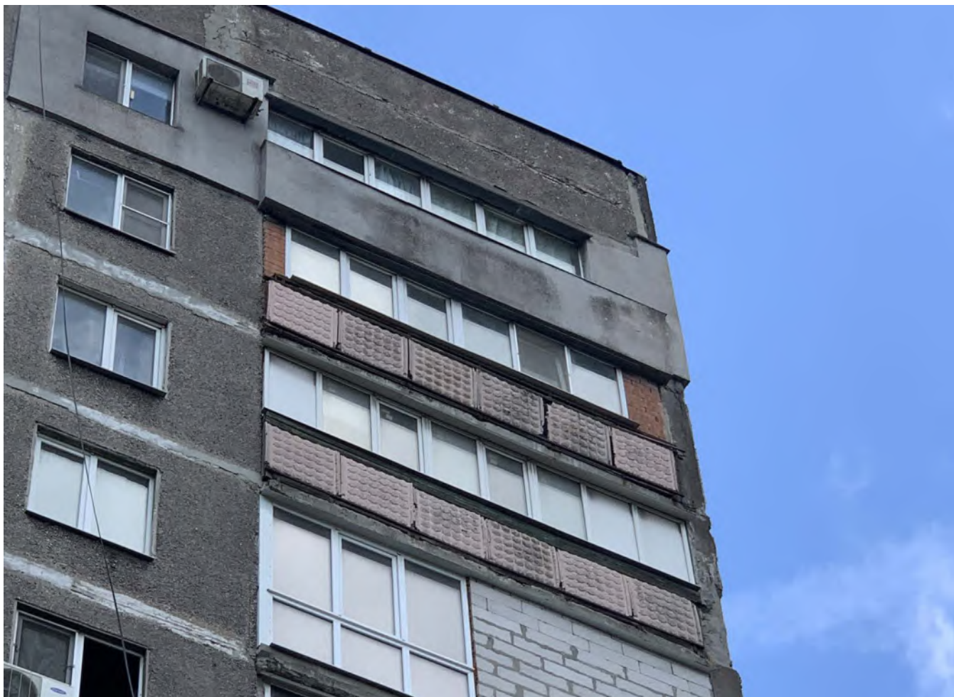
Фото П2.21÷П.2.22. Разрушение фактурного защитного слоя бетона, механическое повреждение стеновых панелей по всем фасадам здания.
