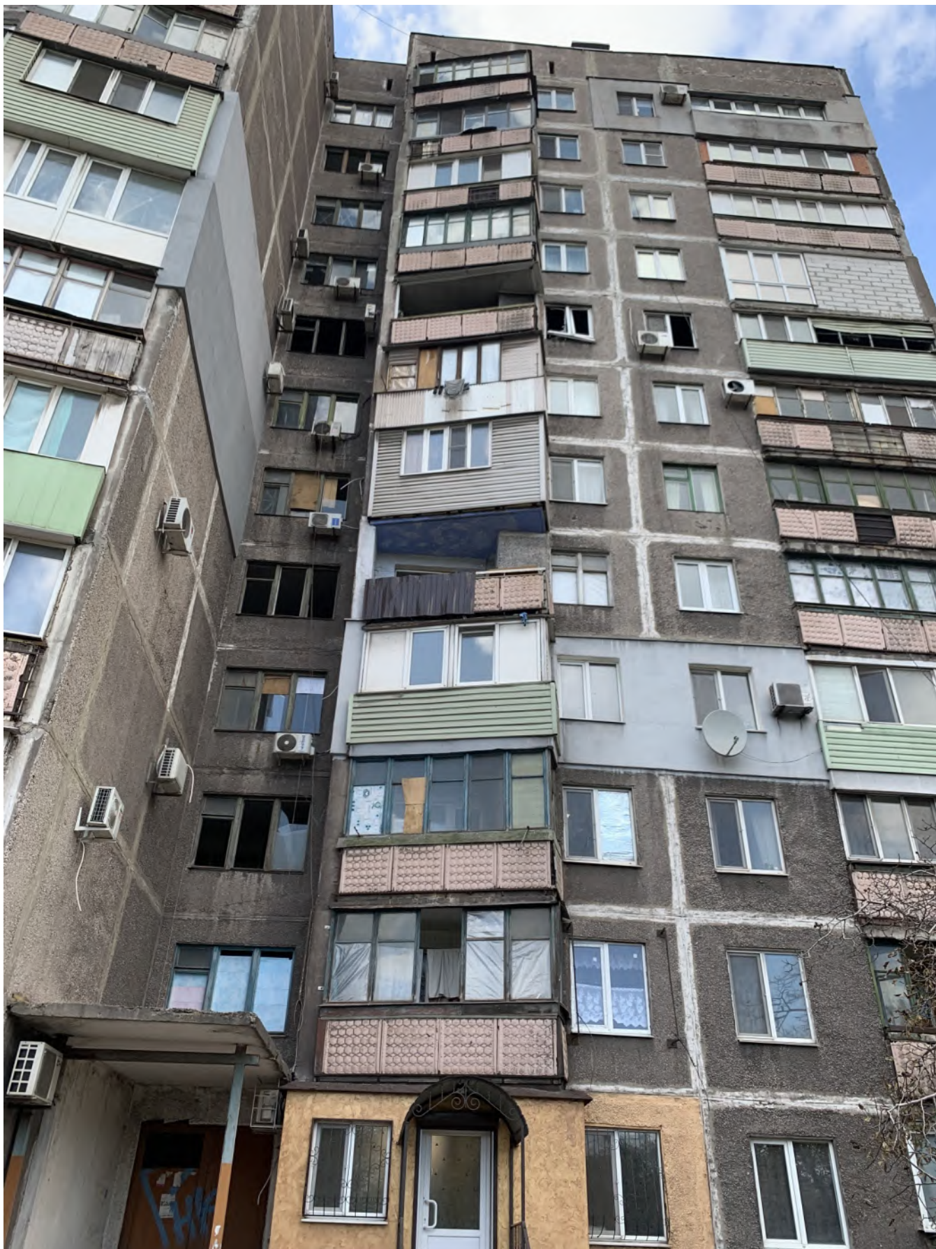
Фото П.2.29. Повреждение остекления, механические повреждения оконных рам; часть заполнения оконных проемов отсутствует.
