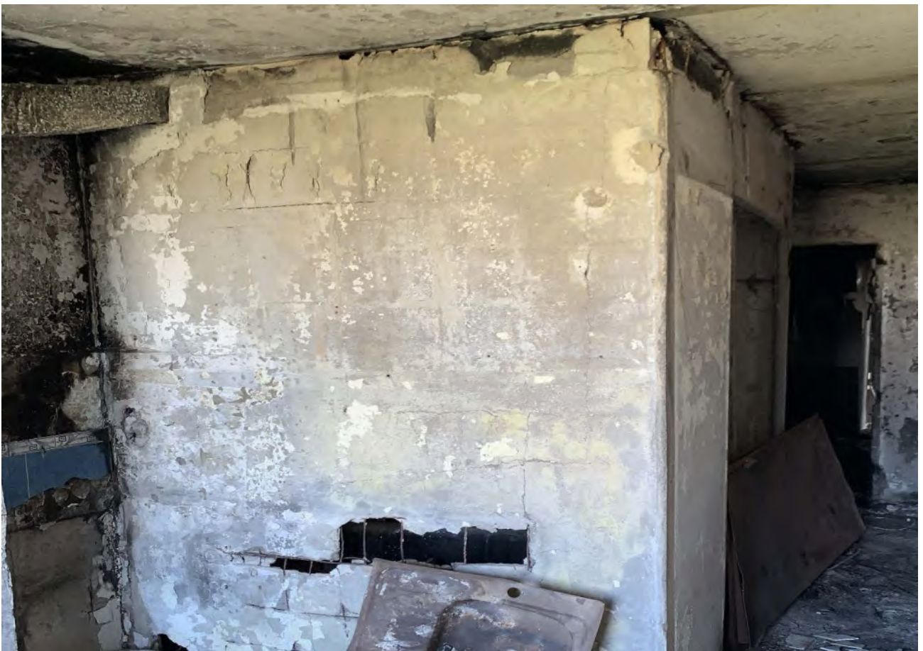
Фото П2.15÷П.2.16. Деформация несущих стеновых панелей и перегородок результате огне- вого воздействия.
