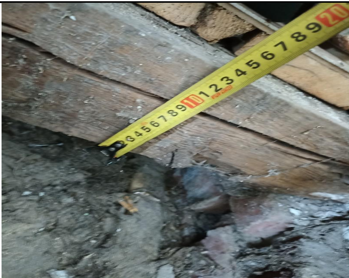
Вскрытие чердачного утеплителя.
